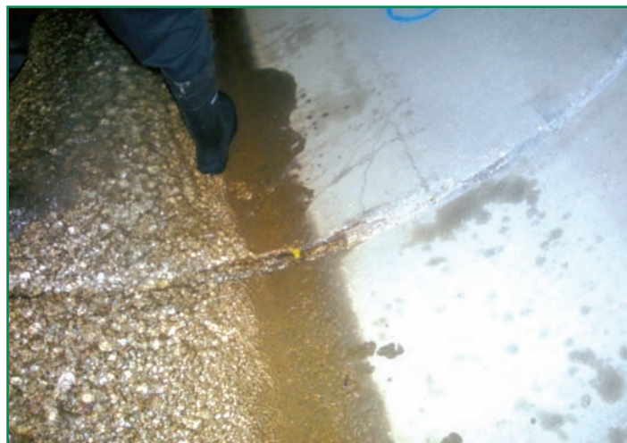
■ [Fig. 7].- Deslavado del hormigón por combinación de lixiviación y abrasión.
