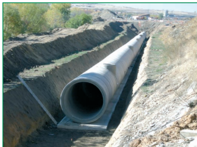
[Fig. 5] .- Emisario de hormigón armado circular.
