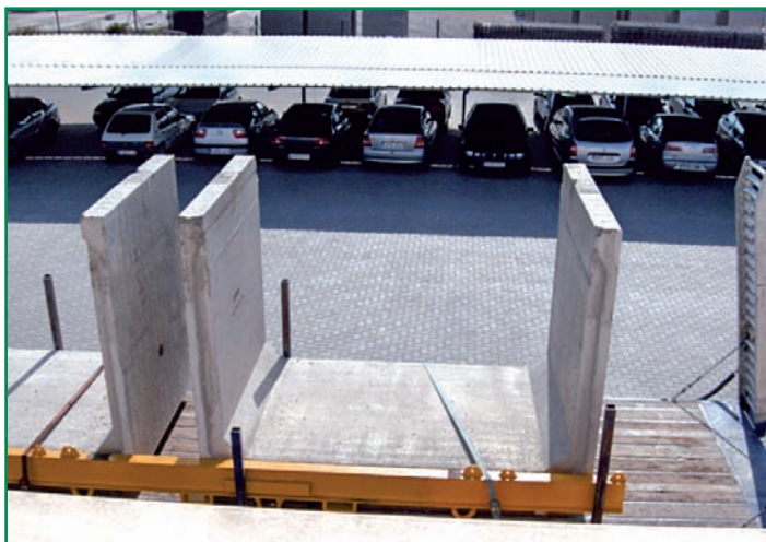
■ [Fig.6].- Canal de hormigón.
