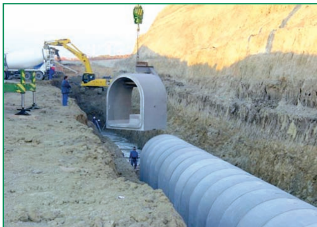
[Fig. 2] .- Instalación de una canalización con galerías de hormigón.
