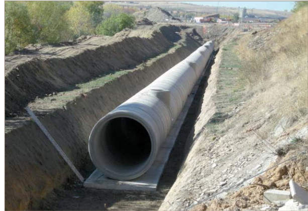
■ Figura 5. Emisario de hormigón armado.
