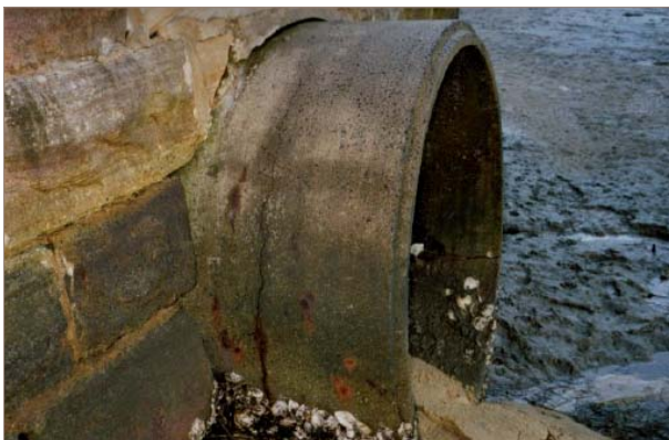
■ Figura 8. Tubería de saneamiento.
