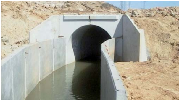
■ Figura 6. Canal de hormigón.
