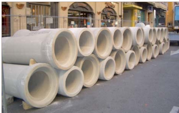
■ Figura 14. Tubos circulares de campana acopiados en obra.
