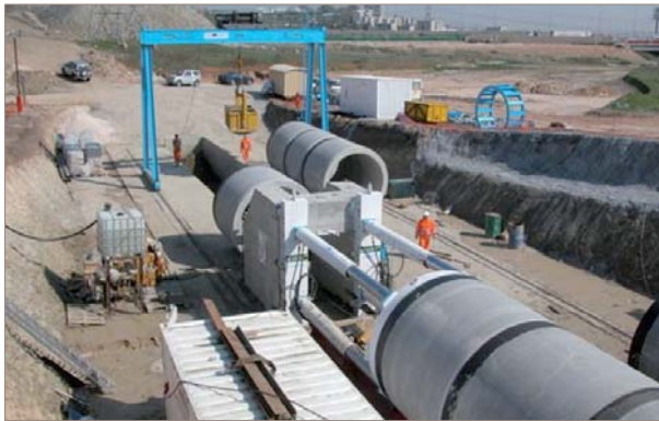
■ Figura 10. Hinca de tubos de hormigón armado.
