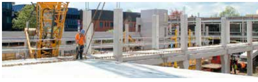
Construcción de la estructura del nuevo edificio de Volkswagen en Brentford (Inglaterra).
