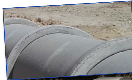
Figuras 18 y 19. Ejemplos de juntas correcta e incorrectamente instaladas
