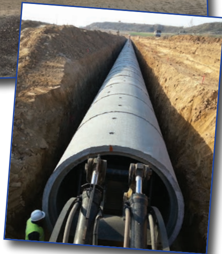
Figura 14 y 15. Maquinaria específica para descarga y montaje de tubos
