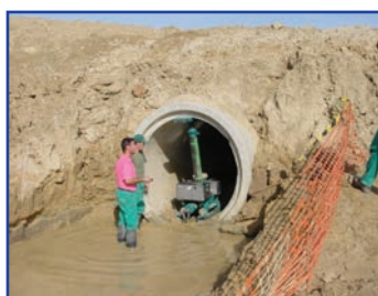
Figuras 16 y 17. Equipos hidráulicos para encaje de la tubería
