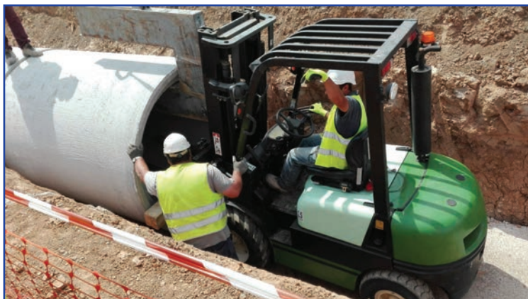
Figura 9. Maquinaria generalista de obra y tubo con daños en la boquilla
