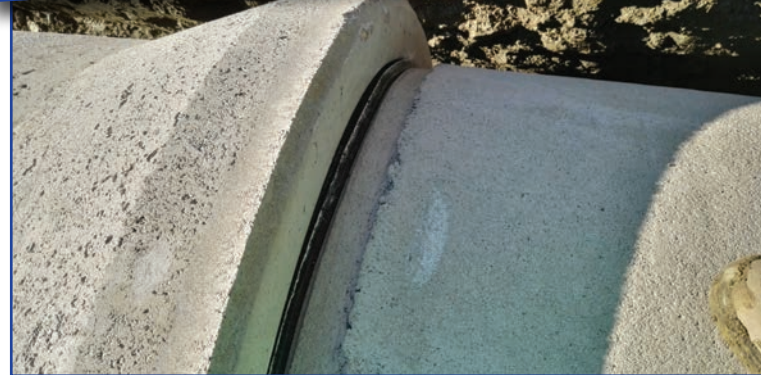
Figuras 18 y 19. Ejemplos de juntas correcta e incorrectamente instaladas
