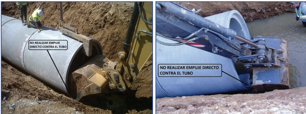
Figura 10. Montaje incorrecto (no realizar empuje directo contra el tubo)
