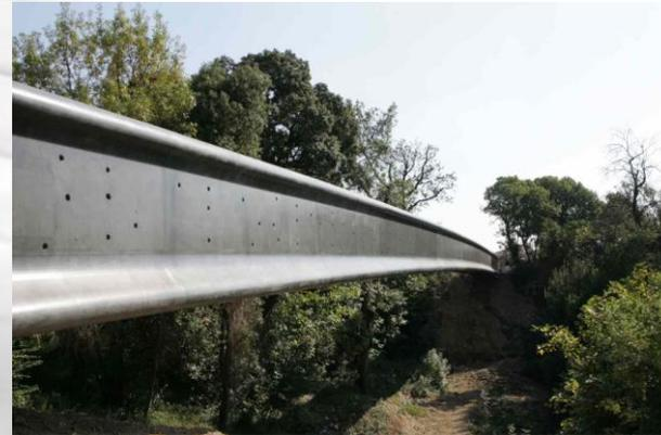
*Técnica del pretensado: tipología de construcción de elementos estructurales de hormigón sometidos intencionadamente a esfuerzos de compresión previos a su puesta en servicio, o postesado si se hace posteriormente.*
