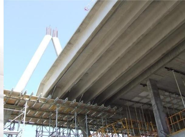
*La obra, situada en el puerto de Denia, incorpora elementos prefabricados de hormigón armado y pretensado de características singulares: los pilares son de sección circular, de 14 metros de altura dispuestos en obra con inclinación de 70°; las placas de forjado son de sección TT de canto 60cm y con luces de 20m.*
