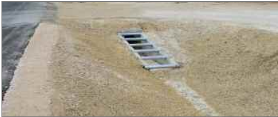
Figura 4.- Vista general del dispositivo para pasos salvacunetas TUBYDER ya instalado
