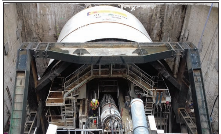
Preparación tuneladora antes del arranque
