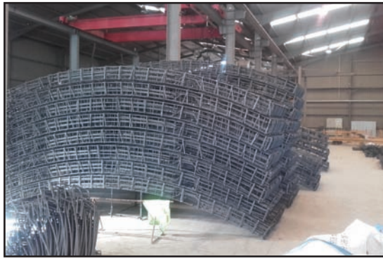
Zona de montaje de armadura
