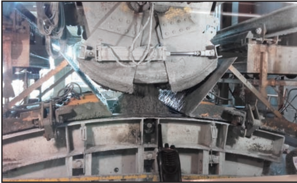
Posición del molde en la cabina de hormigonado
