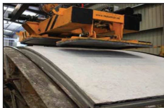
Traslado de Dovelas hacia la volteadora
