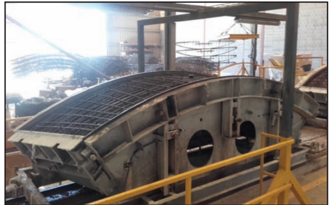
Colocación de la armadura en el molde correspondiente
