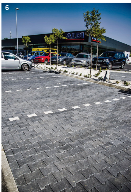
6.- Adoquín Mezquita de PAVIGESA utilizado para zona de aparcamiento en centro comercial.
