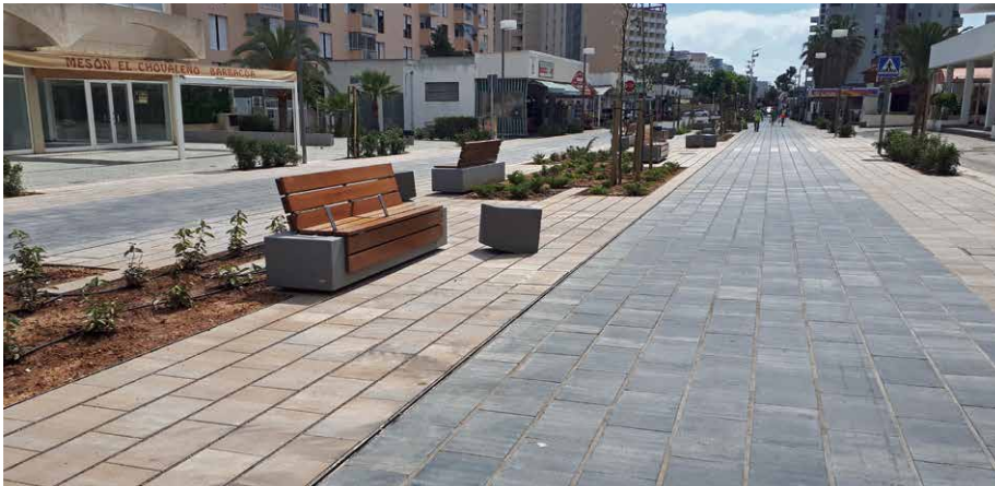
9. Suministro de 2.500 m 2 de losas de 50X29X12 cm con distanciador de 2 cm y tratamiento durobrill para Avda. del Galeón en Magalluf (Mallorca). Fabricante PAVIMENTS LLOSETA.
