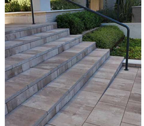
7. Urbanizaciones en zonas de viviendas en varios Barrios de Tres Cantos (Madrid). 10.000 m 2 de losa Bahía 60x40x5 cm, ideal para el confort y garantía de sostenibilidad y seguridad para los residentes en las zonas por su carácter antideslizante. Fabricante: GLS PREFABRICADOS.
