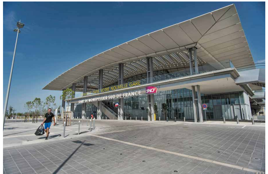
8. Estación de Montpellier (Francia) con el pavimento técnico VS5® (30x20x10 cm) en color "black". Un adoquín capaz de soportar grandes cargas de tránsito y que cuenta con unas ranuras de 8 mm de profundidad que producen un efecto de pinzamiento en el lecho de arena, creando así un efecto de prevención de posibles desplazamientos. Fabricante BREINCO.
