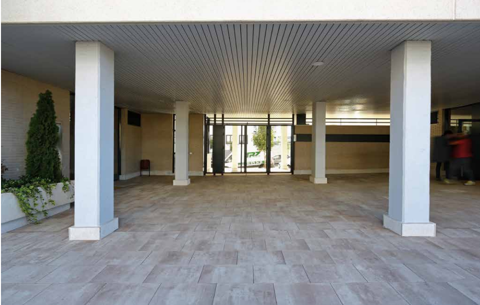
7. Urbanizaciones en zonas de viviendas en varios Barrios de Tres Cantos (Madrid). 10.000 m 2 de losa Bahía 60x40x5 cm, ideal para el confort y garantía de sostenibilidad y seguridad para los residentes en las zonas por su carácter antideslizante. Fabricante: GLS PREFABRICADOS.
