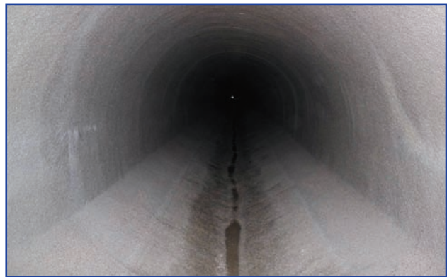
Colector tras el tratamiento con Ombran MHP
