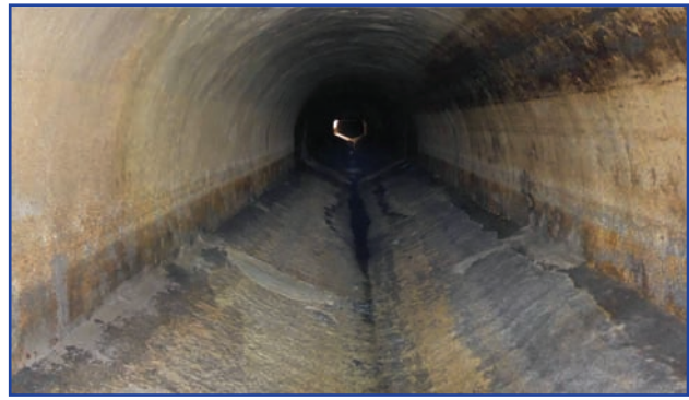
Colector antes del tratamiento con Ombran MHP
