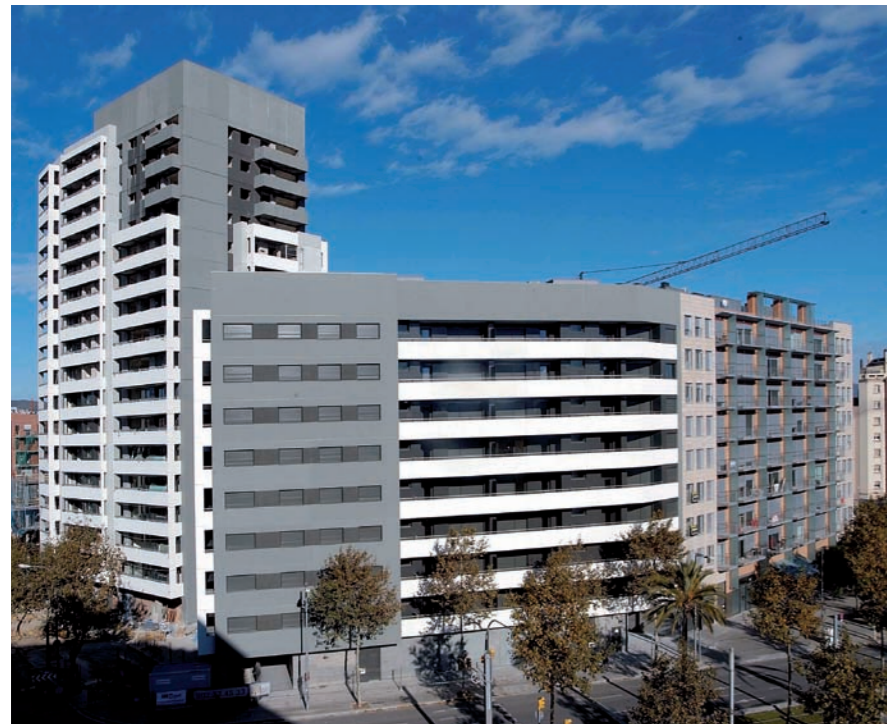
Foto: Prefabricats Planas
