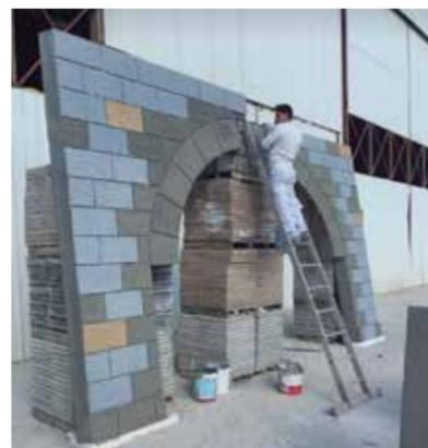
Fachadas de paneles prefabricados de GRC tipo sándwich Ciudad de la Justicia de Córdoba. (Foto cortesía de Prehorquiza)
