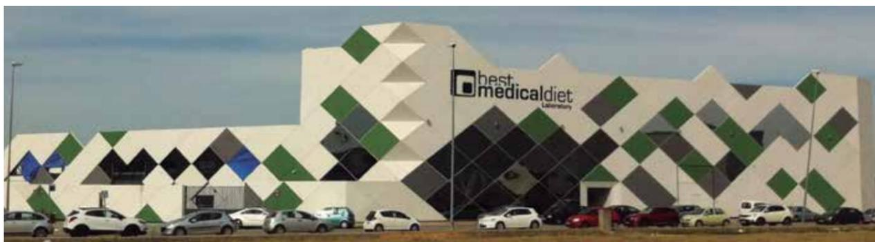
Paneles prefabricados de GRC tipo sándwich en el HQ Best Medical Diet en Alcalá de Guadaíra, Sevilla. (Foto cortesía de Prehorquisa)
