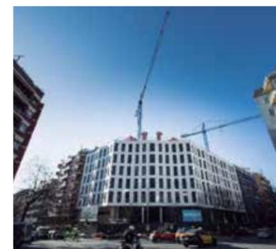
Paneles stud-frame de GRC con acabado liso con veladura blanca, Barcelona. (Foto cortesía de Planas ARK)
