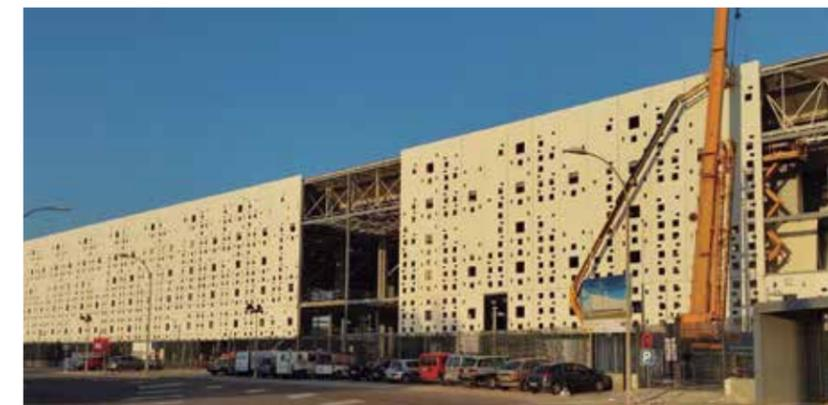
Panel prefabricado de hormigón blanco con acabado liso y perforados con huecos formando celosía, Nuevo Centro de Exposiciones, Ferias y Convenciones de Córdoba. (Foto cortesía de Prefabricados Hermanos Quijada)
