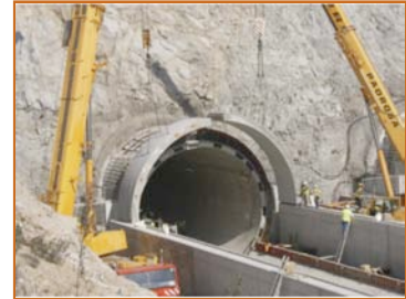
Proceso ejecución del emboquille prefabricado (dovelas triarticuladas) de la boca sur del falso túnel del Perthus de la L.A.V. Figueres-Perpignan. Diseñado el mismo para evitar el boom sónico del tren de alta velocidad.(1/2)
