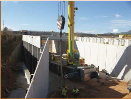
Cajón totalmente hiperestático de dimensiones 12,50x5,50 con hastiales nervado y dintel sección doble T.
