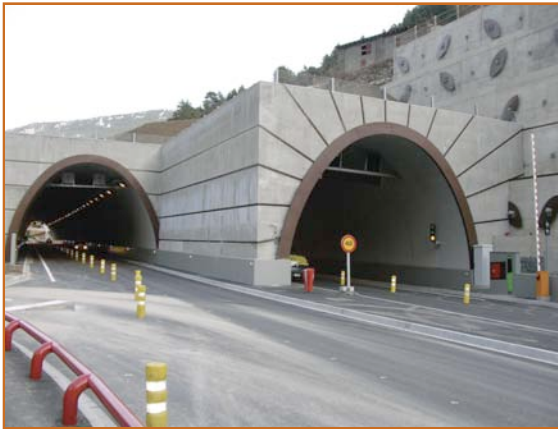
Falso túnel doble de Encamp (Andorra).
