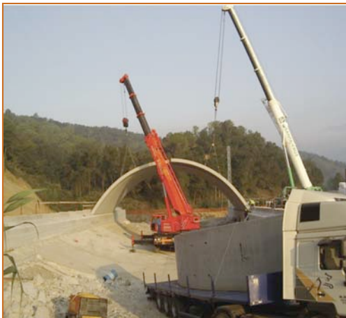
Paso de fauna de 20 metros de luz en la LAV Barcelona-Figueras. Cimentación resuelta mediante contra-bóveda.
