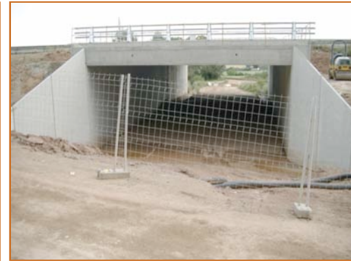
Cajón totalmente hiperestático de dimensiones 12,50x5,50 con hastiales nervado y dintel sección doble T.
