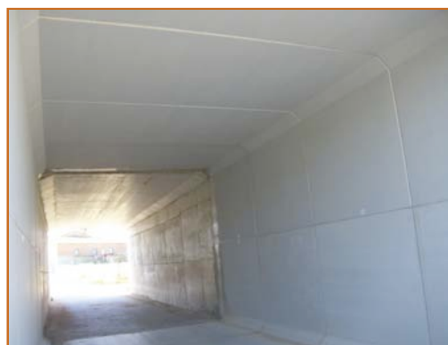
Cajón hiperestático de dimensiones reducidas (5x4)
