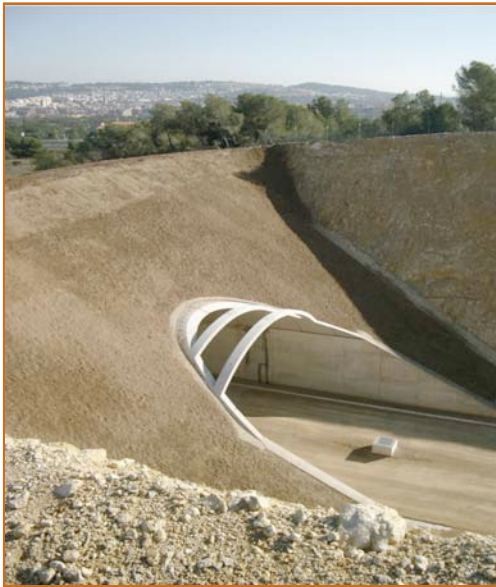
Falso túnel de 600 metros en la LAV Madrid-Barcelona en Vendrell. Bóveda triarticulada sobre hastiales hormigonados contra la excavación. Pico de flauta tipo arco o con costillas. Derecha: emboquille Eix Diagonal.
