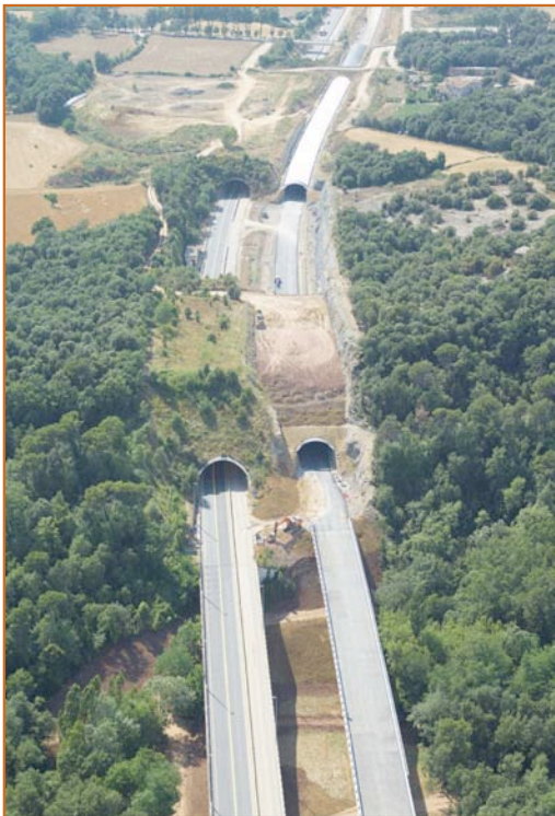
Falso túnel doble de Encamp (Andorra).
