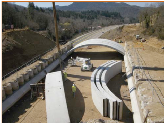
Falso túneles biarticulados. Falso túnel de Coll de Revell y de Sant Julia (Eix Transversal)
