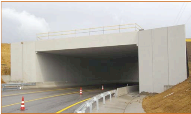
Cajón hiperestático de dimensiones interiores 16x7,20 metros, resuelto mediante hastiales macizos, losa cimentación in-situ y dintel binervado.
