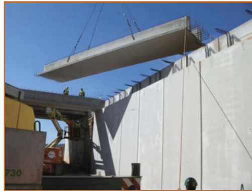
Cajón totalmente hiperestático de dimensiones 12,50x5,50 con hastiales nervado y dintel sección doble T.
