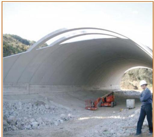
Paso de fauna de 20 metros de luz en la LAV Barcelona-Figueras. Cimentación resuelta mediante contra-bóveda.
