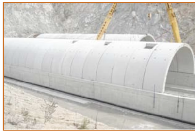
Proceso ejecución del emboquille prefabricado (dovelas triarticuladas) de la boca sur del falso túnel del Perthus de la L.A.V. Figueres-Perpignan. Diseñado el mismo para evitar el boom sónico del tren de alta velocidad.(1/2)
