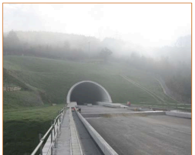
Falso túnel doble de 400 metros de longitud cada ojo en el tramo Lleida-La Cerdera. Solución estructural falso túnel triarticulado. Dcha Emboquille la LAV en la Y vasco (tramo vizcaíno)
