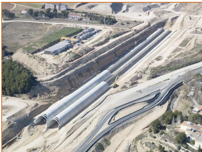
Falso túnel doble de 400 metros de longitud cada ojo en el tramo Lleida-La Cerdera. Solución estructural falso túnel triarticulado. Dcha Emboquille la LAV en la Y vasco (tramo vizcaíno)
