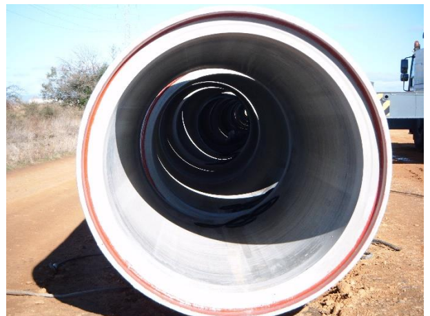
Imágenes.- Tuberías de hormigón con camisa de chapa, armada y postesada respectivamente
