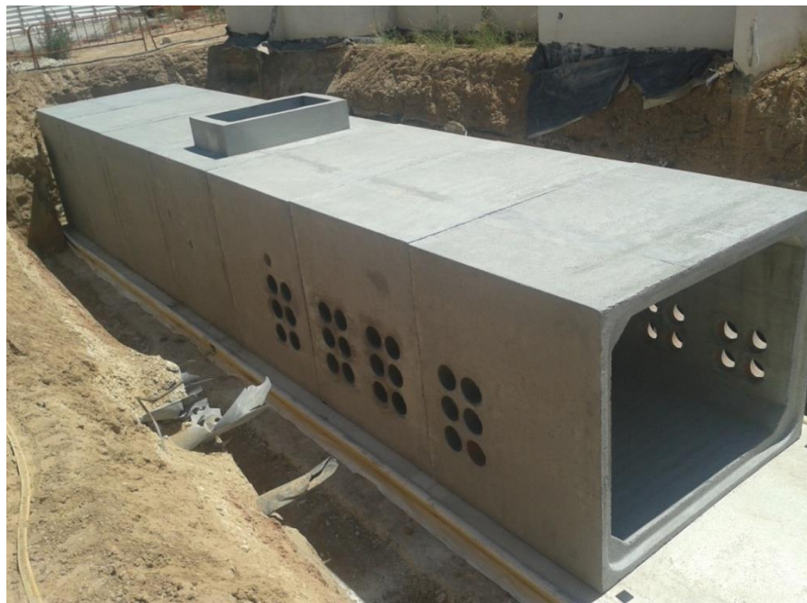
Figura.- Cámara de empalme de cables eléctricos
