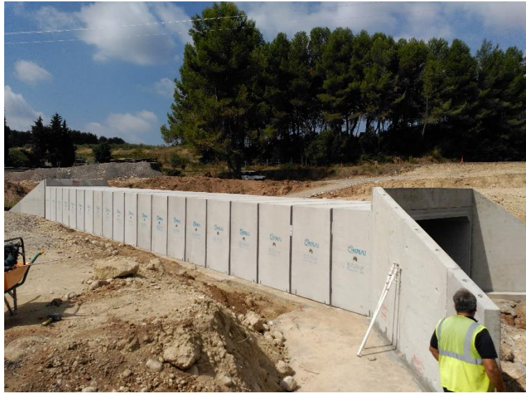
Figura.- Obra de drenaje transversal
