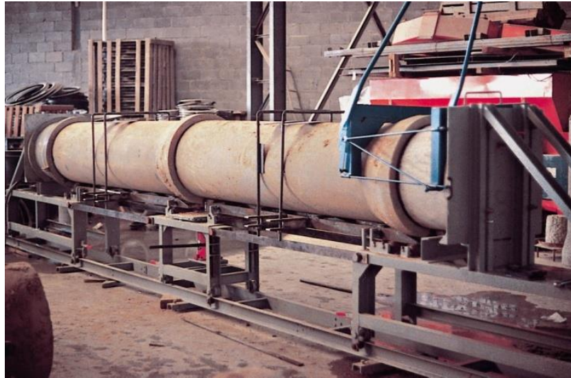
Figura.- Prueba de estanquidad de los tubos realizado en la propia planta de prefabricación
