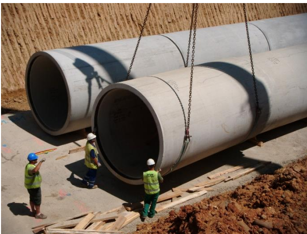
Imágenes.- Tuberías de hormigón con camisa de chapa, armada y postesada respectivamente
