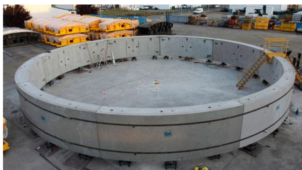
Figura.- Dovelas para Alaskan Way Viaduct en Estado Unidos
