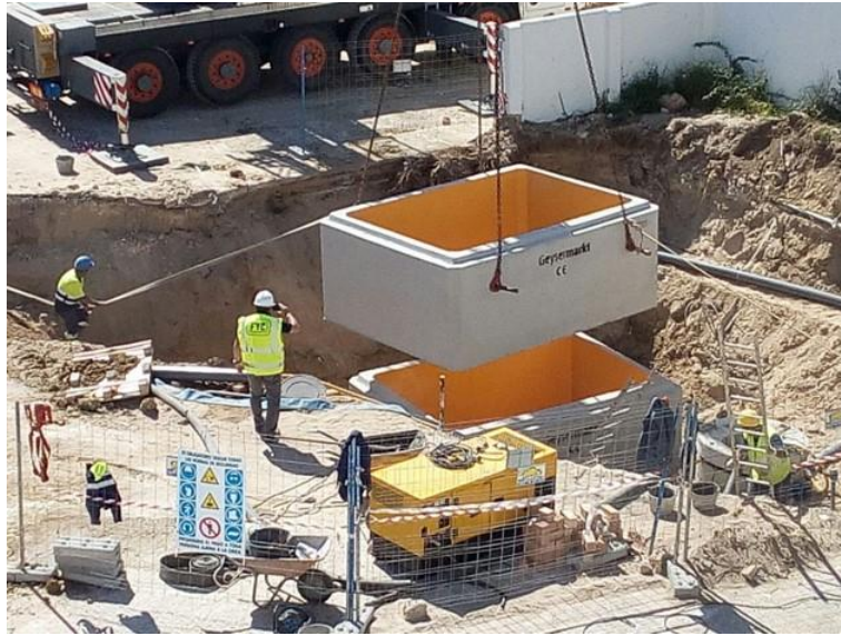
Figura.- Instalación de arquetas de grandes dimensiones
