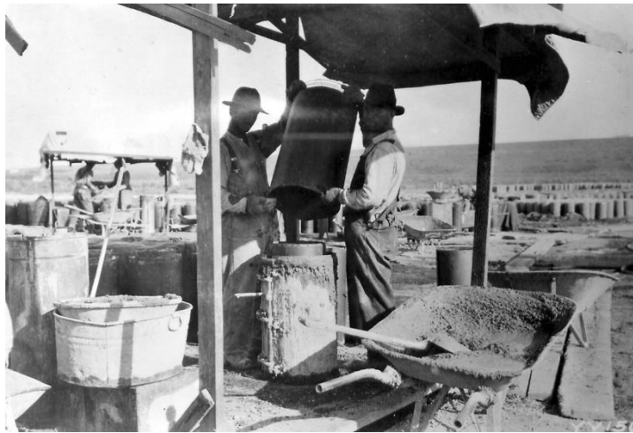
Figura.- Fabricación tubo de hormigón de 300 mm (12") de diámetro en 1911 para el Proyecto Yakima en Washington (Estados Unidos)
