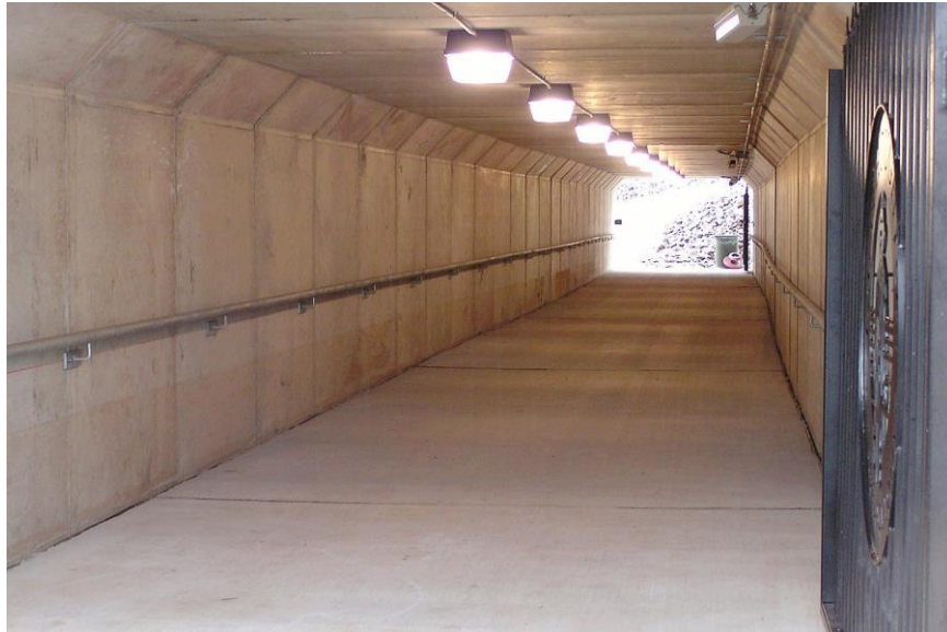
Figura.- Paso subterráneo con marcos prefabricados de hormigón
