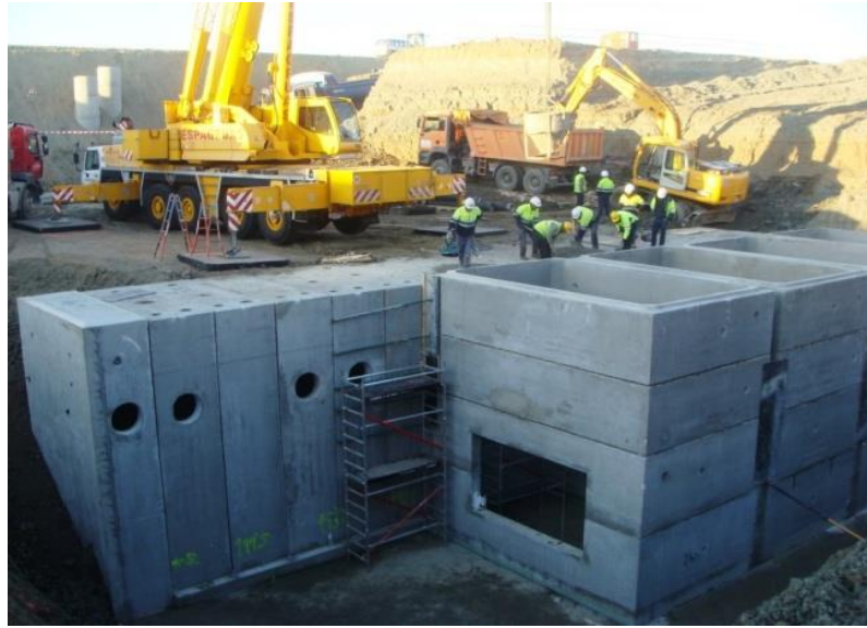
Figura.- Tanque de tormenta con marcos prefabricados de hormigón
