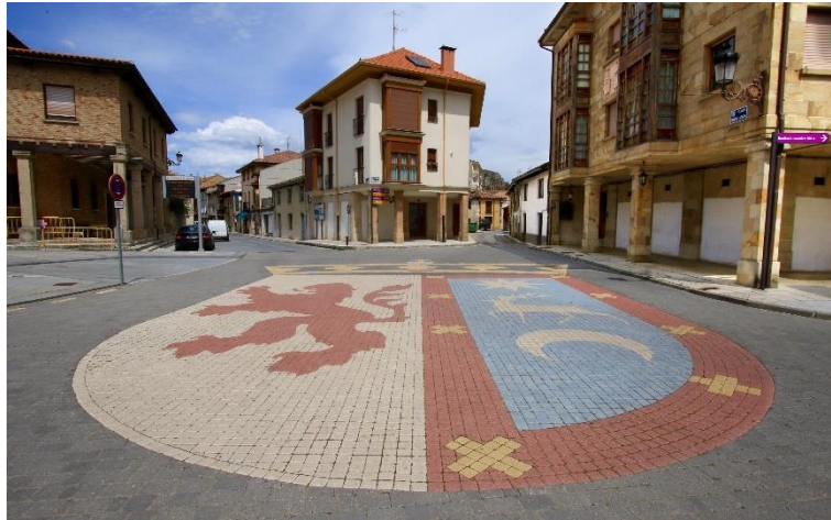
Figura.- Pavimentación de la Plaza del Ayuntamiento de Cervera de Pisuerga (Palencia). 1.050 m 2 . Un estudiado diseño para ejecutar el escudo de la localidad con adoquines de hormigón 10x10x6 cm envejecido en varios colores
