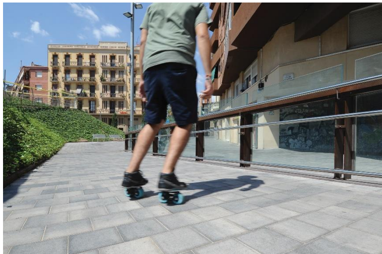
Figura.- Pavimento descontaminante para el High Line de Sants (Barcelona)
