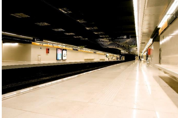
Figura.- Estación de metro con baldosa como pavimento, baldosa táctil, revestimiento vertical y bancos
