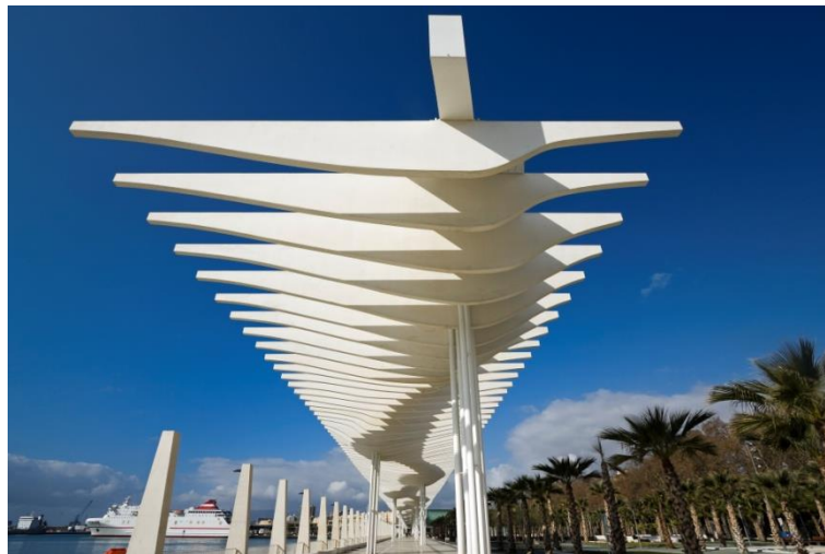
Figura.- Marquesina prefabricada de hormigón en el puerto de Málaga (España). Cumple simultáneamente dos objetivos: uno funcional (proyectar sombra a las personas que caminen por el paseo marítimo) y estética (característica demandada en este tipo de zonas)
