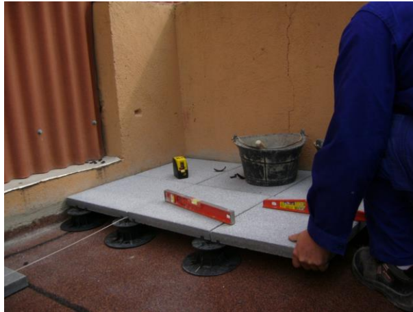
Figura.- Ejecución baldosas flotantes
