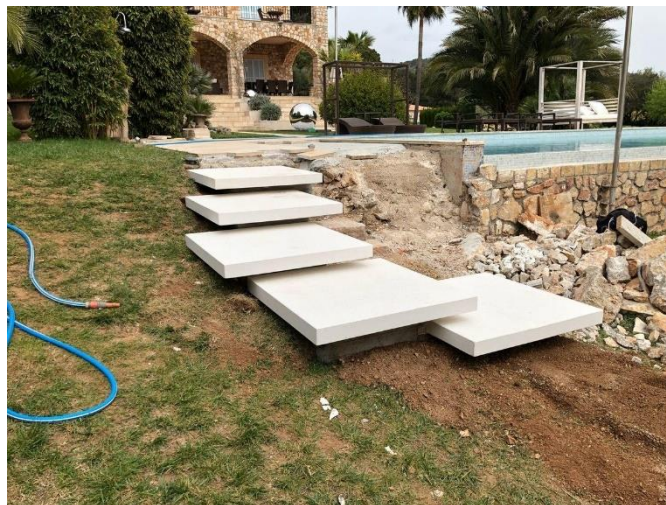
Figura.- Baldosas de hormigón de gran formato para salvar desniveles
