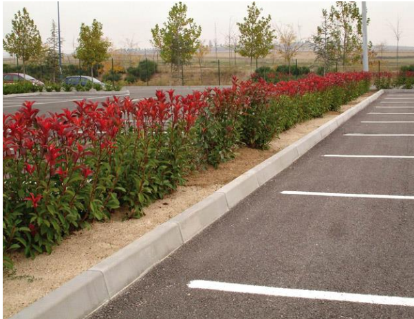
Figura.- Limitación de zona ajardinada con bordillo
