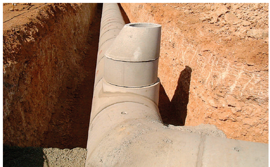
↓ Vista de canalización ya colocada antes del relleno.
