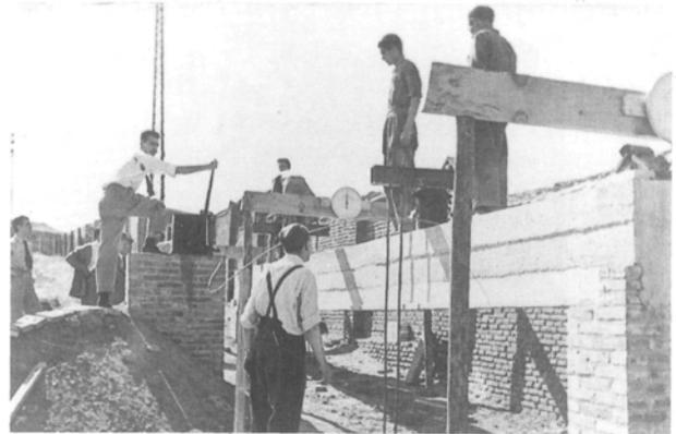
Fig. 5.- Ensayo para la fabricación de las vigas del primer puente pretensado de España, en 1951. Realizado por E. Torroja.
