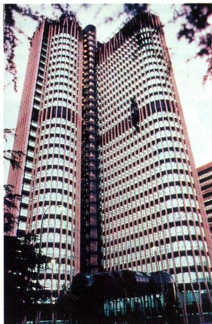
Fig. 52.- Edificio de 110 m de altura en Madrid, realizado con elementos prefabricados de gran precisión técnica y con acabado tratado al chorro de arena. Década de 1980. Arquitecto Miguel de Oriol. Década de 1980.
