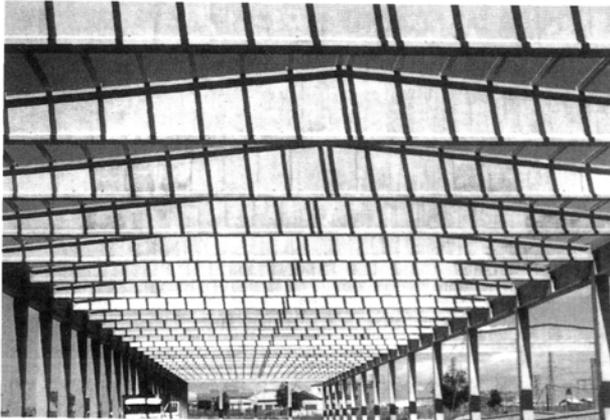
Fig. 42.- Cobertura de una gran superficie, realizada con pilares prefabricados y jácenas peraltadas. Década de 1970
