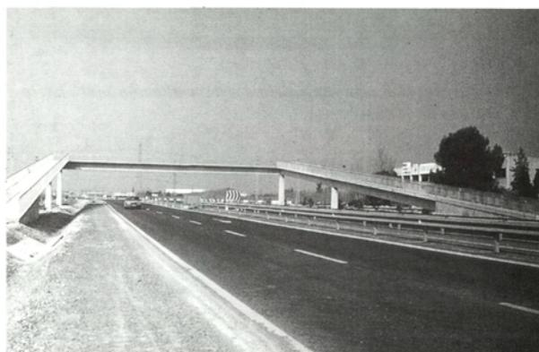
Fig. 55.- Pasarela prefabricada con vigas tipo Gaviota.
