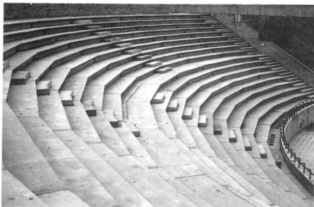
Fig. 57.- Graderios prefabricados para el Estadio de Teruel. Realizado en colaboración con el arquitecto Federico Echevarría. Década de 1980.
