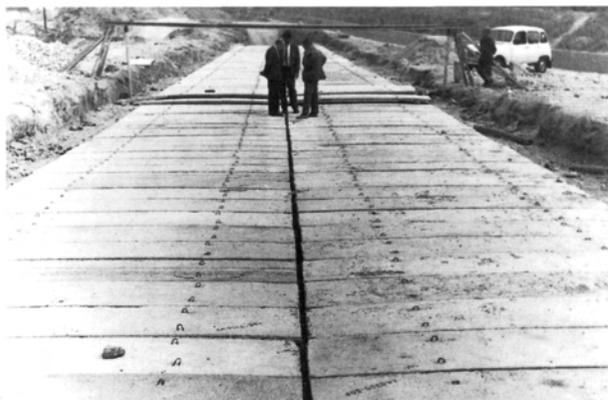
Fig. 22.- Cobertura realizada con losas prefabricadas pretensadas de 6 cm de espesor.
