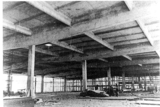
Fig. 16.- Cubierta de una gran superficie realizada con elementos prefabricados pretensados.
