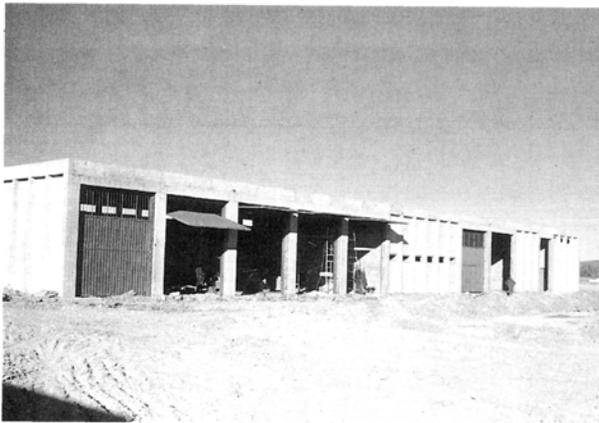
Fig. 48.- Áreas de servicio totalmente prefabricadas. Zona de carga. Principios de los años 80.
