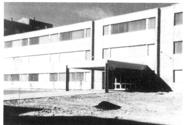
Fig. 51.- Fachada de las escuelas prefabricadas que incluye elementos de cierre y estructurales.
