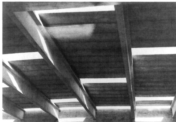
Fig. 21.- Forjado de vigas y losas prefabricadas pretensadas.
