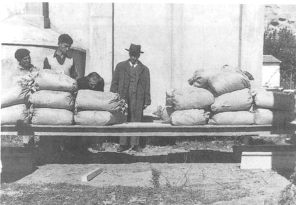
Fig. 4.- Prueba de carga de viguetas prefabricadas pretensadas. Controla el ensayo Francisco Fernández Conde.
