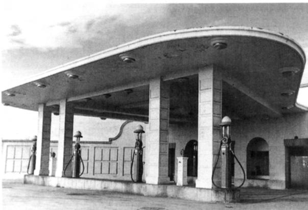
Fig. 15.- Forjado de cubierta de una gasolinera realizado con viguetas pretensadas. Década de 1950.
