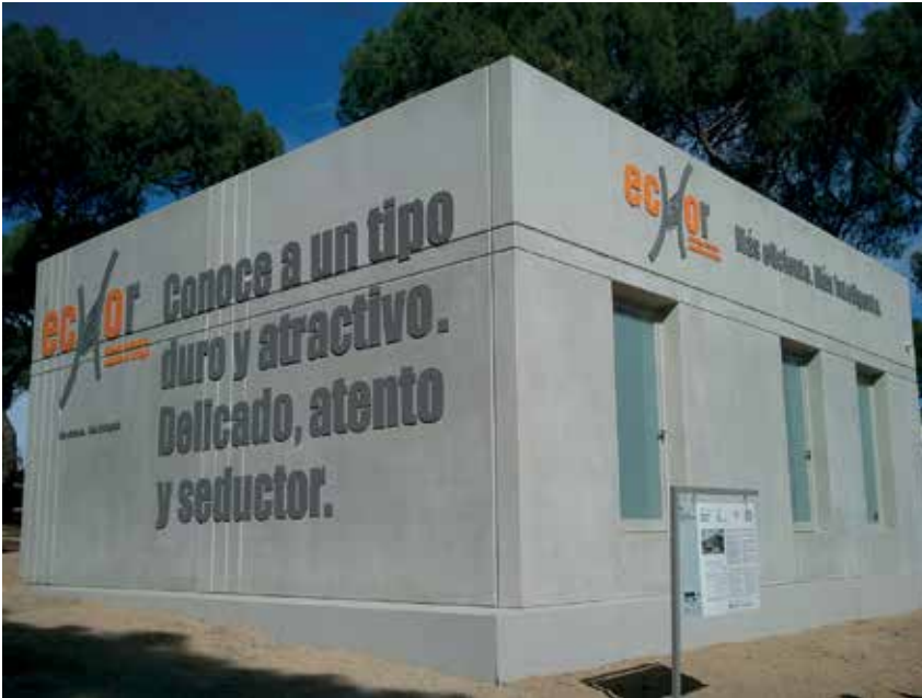
Figura 3.- Edificio ECHOR, construcción totalmente prefabricada en hormigón presentada en el certamen internacional Solar Decathlon celebrado en Madrid en 2012 4 , que sirvió de ejemplo para demostrar la alta inercia térmica de los edificios cerrados con hormigón
