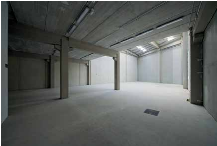
Figura 4.- Otros tipos de edificaciones como la industrial, la comercial o la logística, apuestan ya por la industrialización en hormigón. El paso decidido a su empleo dentro de los edificios residenciales, serán sólo una cuestión de aceptación por parte de proyectistas y usuarios.
