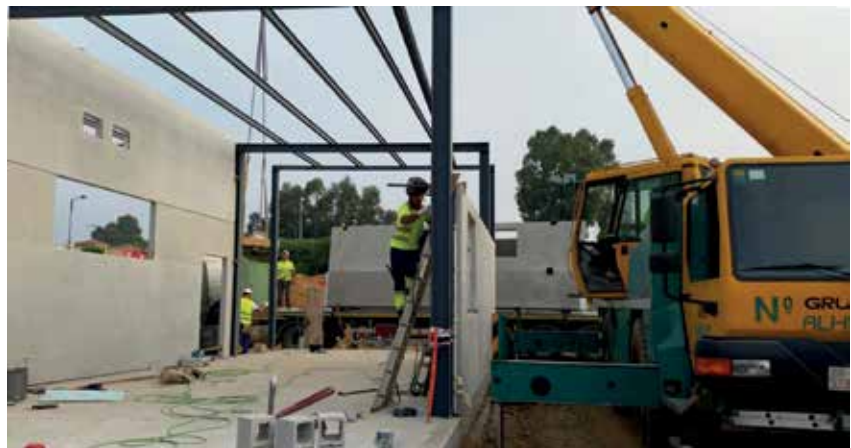
Figura 6.- Montaje de paneles prefabricados "sandwich", con aislamiento térmico incorporado y rotura de puente térmico. Fotografía cortesía de PREFABRICADOS HERMANOS QUIJADA
