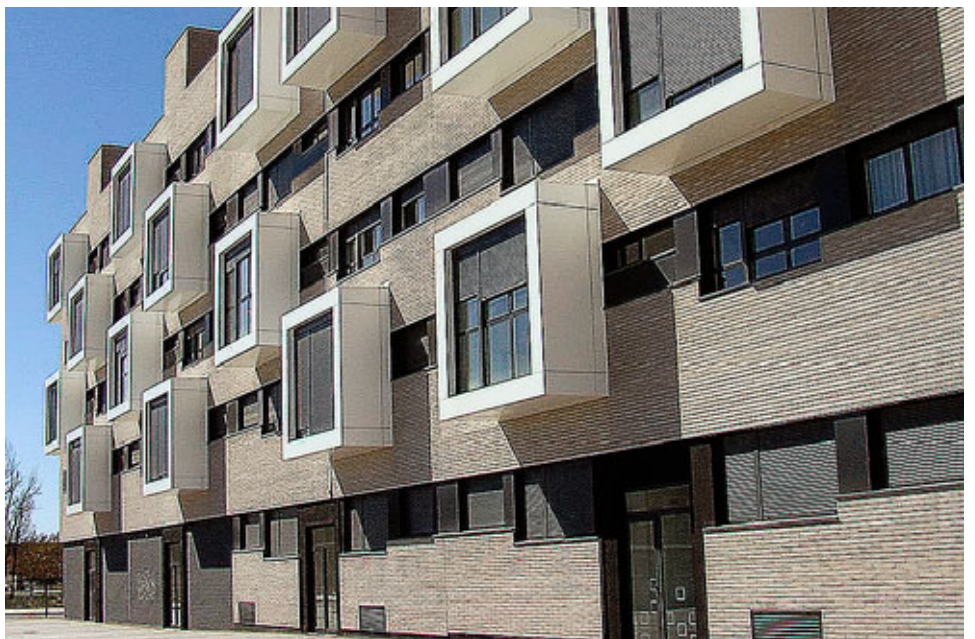
IMAGEN DE UN EDIFICIO CON LADRILLO DE HORMIGÓN EN EL S-3 CEDIDA POR BLOQUES BARRUCA.
