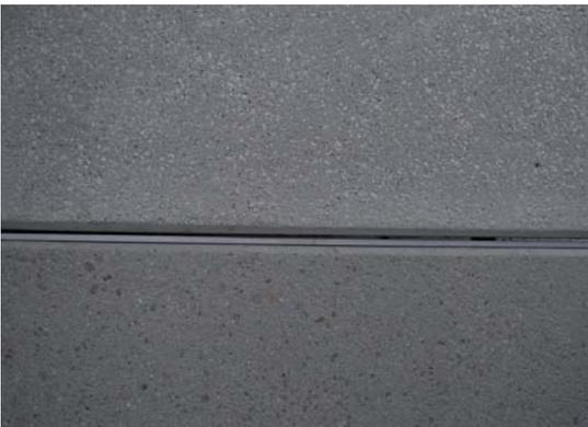
**Árido en relieve.** Acabado de árido visto, que va desde unas décimas de milímetro hasta varios milímetros, esta vez mediante el empleo de un papel o imprimaciones que retardan el fraguado del hormigón, eliminándose al desencofrar esta parte de la lechada con agua a presión.
