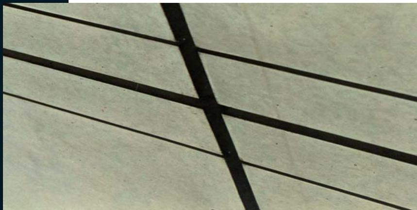
**Texturizado.** Acabado de los paneles mediante el empleo de moldes con el negativo de las texturas a obtener. Se recomienda la elección de relieves o acabados que eviten la formación de depósitos de suciedad.
