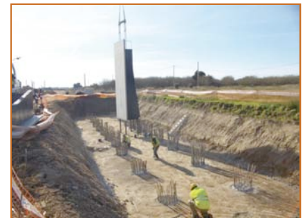
Figura 3. Vista de pilotes sobre los cuáles se ejecutará el encepado de empotramiento de los muros prefabricados/Sección transversal cimentación con pilotes
