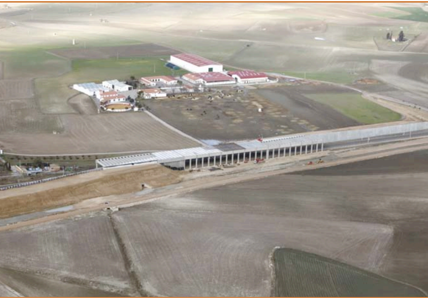
Figura 6a. Pérgola L.A.V. MADRID-VALENCIA CON L.A.V. MADRID-SEVILLA
