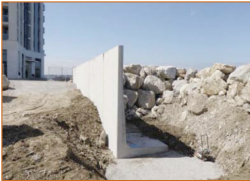
Figura 1. Ejemplos de Muroles (Muros con zapata prefabricada)
