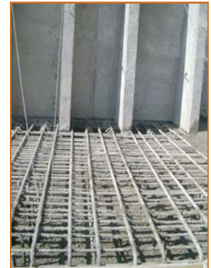
Figura 2. Proceso de ejecución de un muro nervado en ménsula.
