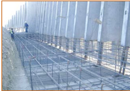
Figura 2. Proceso de ejecución de un muro nervado en ménsula.
