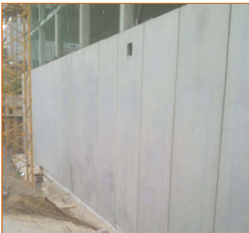
Figura 7 Muro sótano. Con panel simplemente apoyado en cimentación y acodalado en cada forjado.
