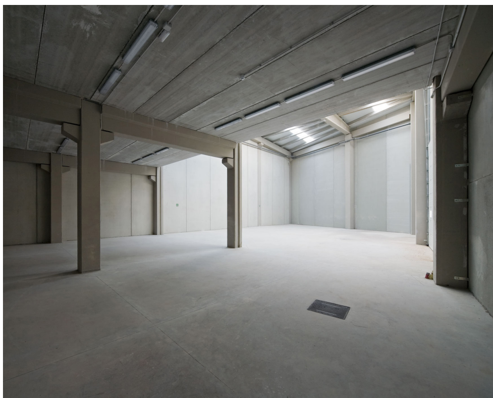
↑ Figura 3. Estructura íntegramente en prefabricado de concreto. La precisión dimensional es requisito clave para asegurar la transmisión de los esfuerzos y la funcionalidad del edificio
