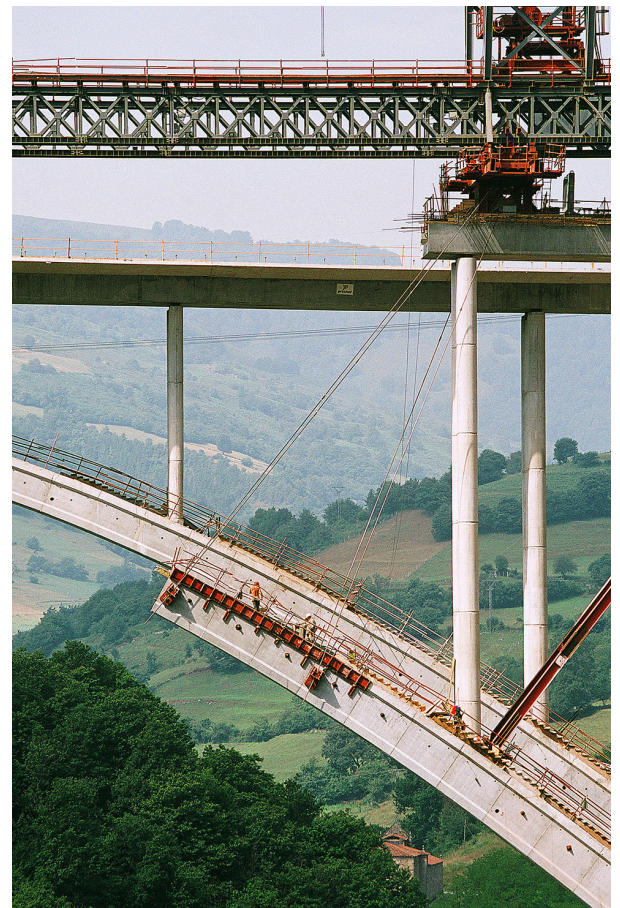
↑ Figura 2. Los puentes y otras infraestructuras de alto coste y gran envergadura requieren una mayor vida de servicio y menores tareas de mantenimiento, por su dificultad para llevarlas a cabo. Recurrir a soluciones en prefabricado de concreto permite asegurar estos condicionantes
