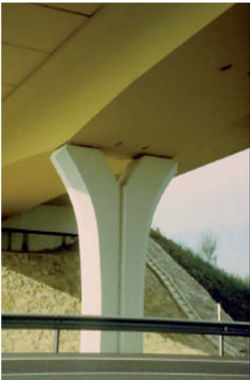
Figura 46.- Pilas de columnas independientes con capitel simple.
