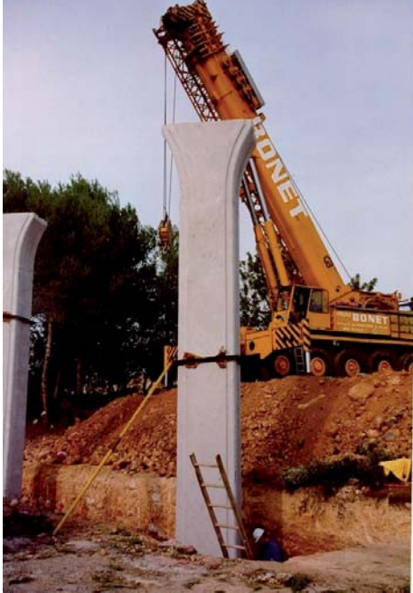
Figura 45.- Pilas de columnas independientes con capitel simple.
