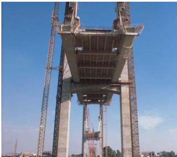
Figura 21.- Puente atirantado con tablero prefabricado en construcción.
