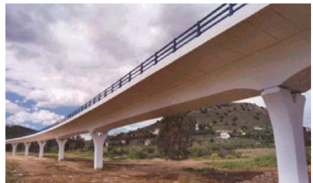
Figura 27.- Puente con tableros de monovigas de planta curva y canto variable.
