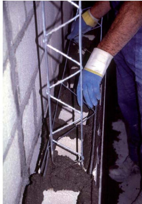
Figura 5.- d) Solapado de la armadura Murfor del paño derecho acometiendo la costilla AllWal
