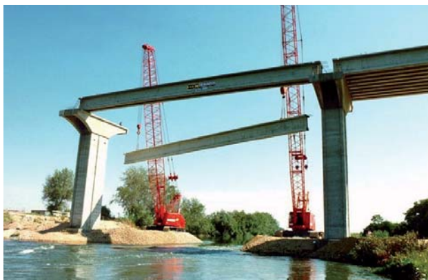
Figura 24.- Puente con tableros de vigas I.
