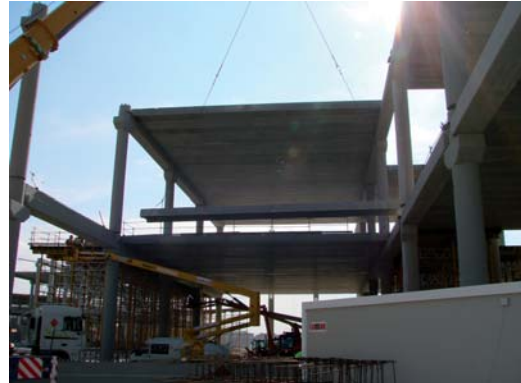
Figura 11 a 14.- Velocidad de colocación en obra.
