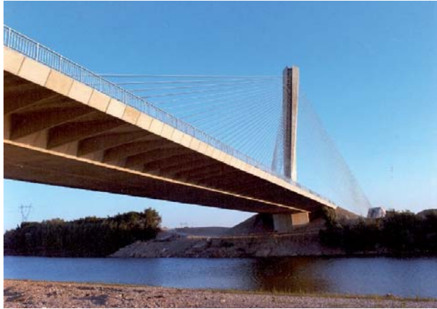
Figura 9.- Puente sobre el Río Ebro - Autopista de Navarra.
