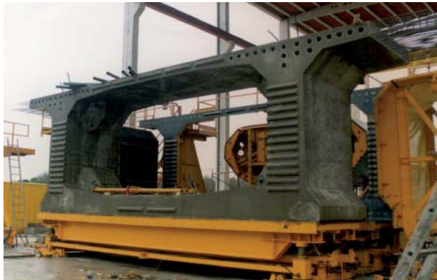
Figura 36.- Dovela de sección parcial en la planta de prefabricación.
