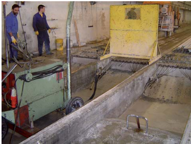
Figura 2.- Tesado de armaduras.
