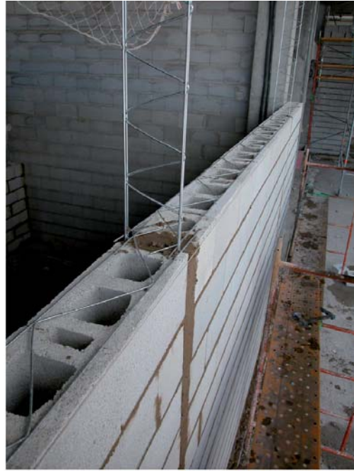
Figura 5.- d) Solapado de la armadura Murfor del paño derecho acometiendo la costilla AllWal
