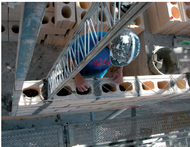
Figura 16.- a) Ejecución del cerramiento de 7m de alto del Hotel Marqués de Riscal en un paño recto con dobles costillas reforzadas.
