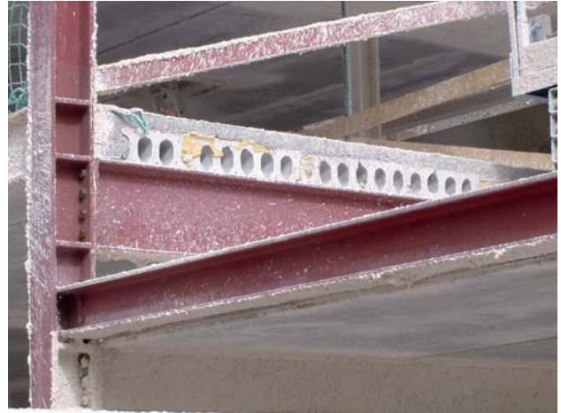
Figura 15.- Capa de compresión y junta hormigonada.
