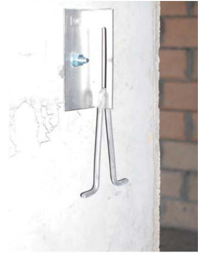
Figura 9.- b) Imagen de un caso de costilla embutida lateralmente dentro de la pieza del BLOC+.
