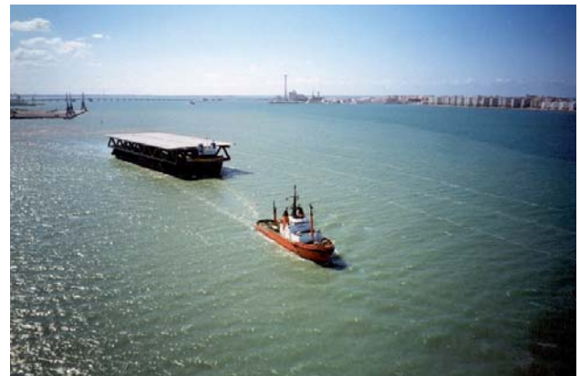
Figura 41.- Puente de Oresund. Transporte por mar.
