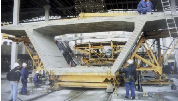
Figura 35.- Dovela de sección completa en la planta de prefabricación.
