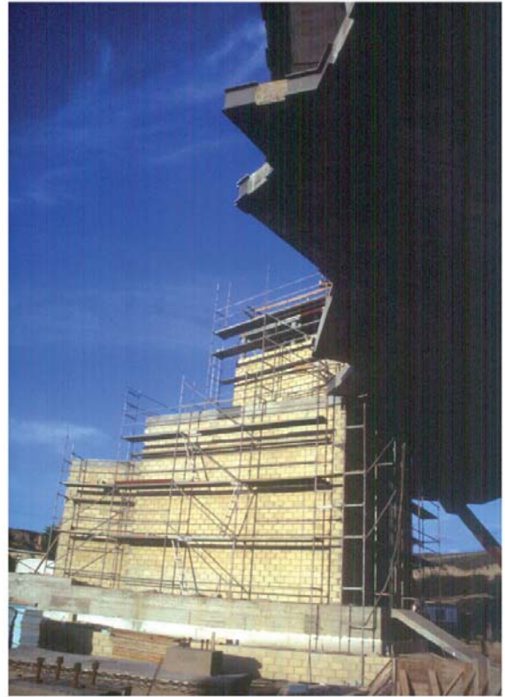
Figura 16.- b) Cerramiento de 3m de altura con costillas en un paño curvo.
