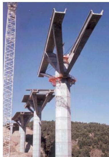
Figura 18.- Puente con tableros soportados por jabalcones en construcción.
