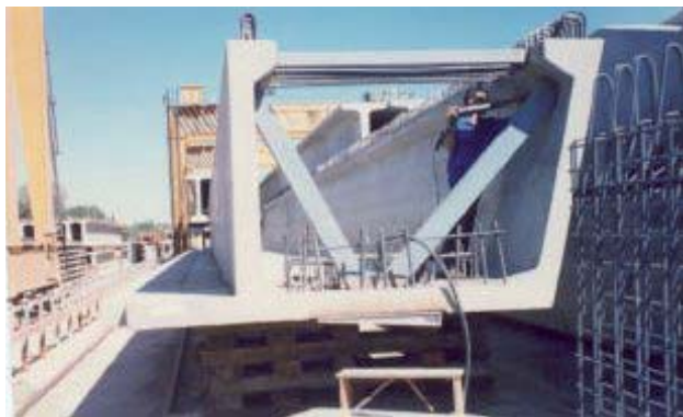
Figura 28.- Viga U para puente de ferrocarril con junta longitudinal para formar un cajón tricelular.
