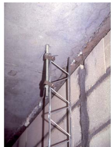
Figura 7.- a) Fijación AllWall inferior Alfa. b) Fijación AllWall superior Beta. c) Fijación Telescópica de la Costilla AllWall al forjado superior.
