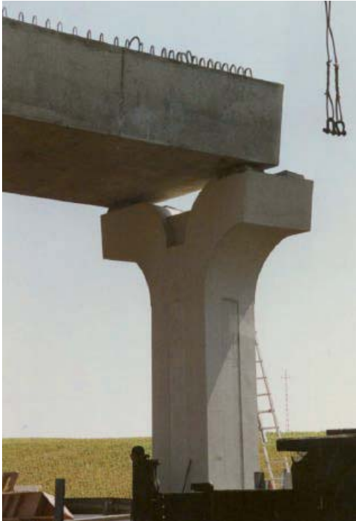
Figura 12.- Puentes con tableros prefabricados de monovigas.
