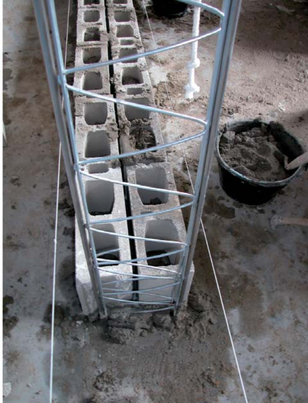
Figura 13.- b) Muro doble anterior con la costilla atando ambas hojas de BHH de 15cm de grueso.
