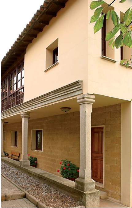
Figura 4.- Empleo de mampostería de hormigón en edificación residencial.
