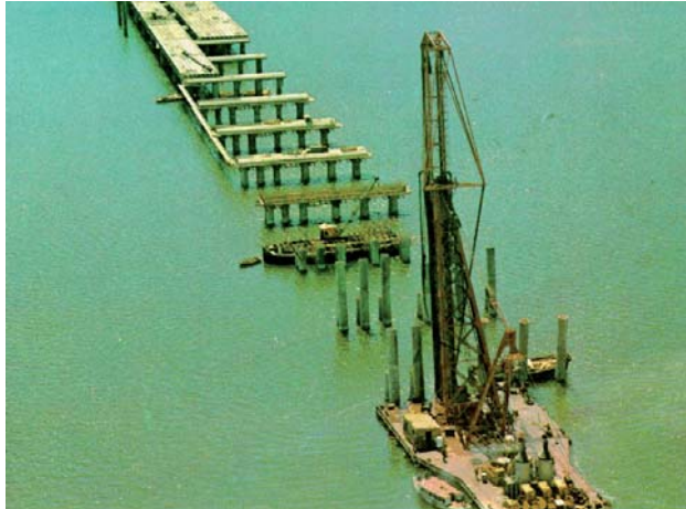
Figura 2.- Puente sobre el Río Tinto.
