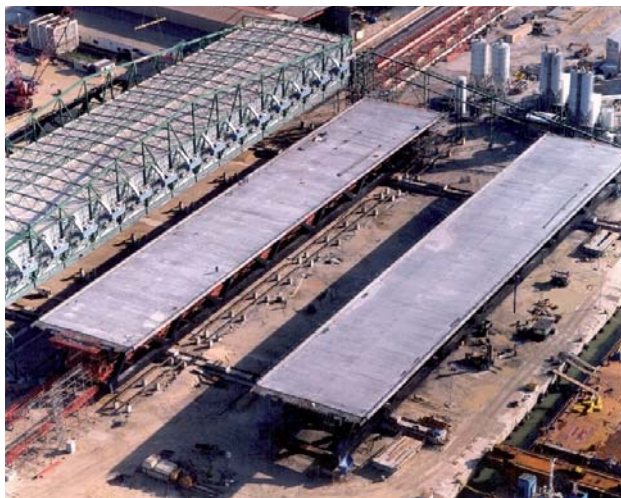
Figura 40.- Puente de Oresund. Planta de prefabricación.
