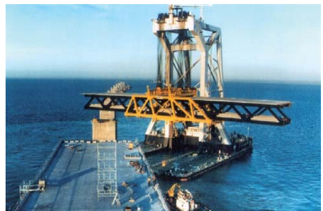
Figura 42.- Puente de Oresund. Instalación sobre las pilas mediante una enorme grúa.
