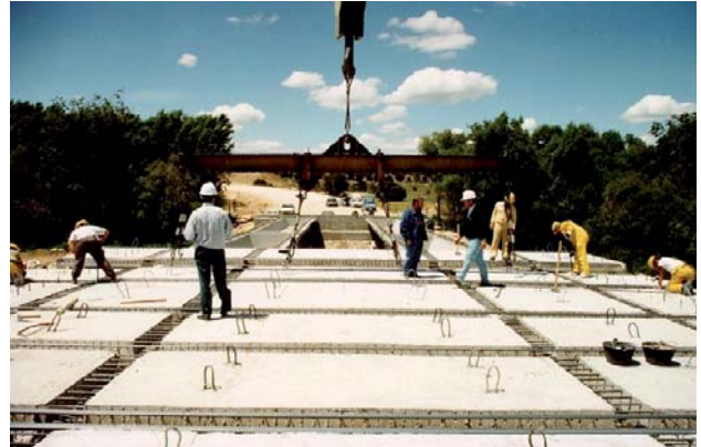
Figura 33.- Losas prefabricadas de tablero con espesor total.
