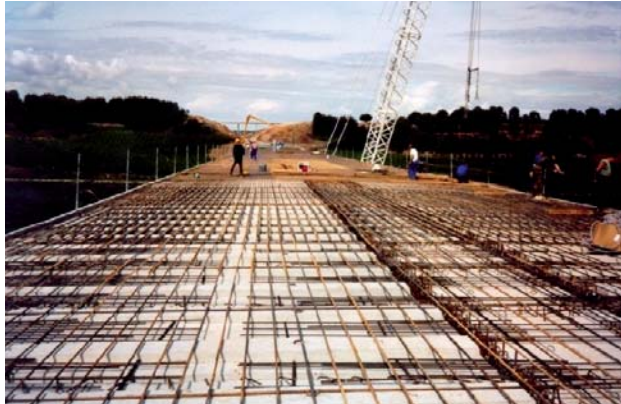
Figura 31.- Parrilla de armadura superior colocada sobre prelosas de tablero.
