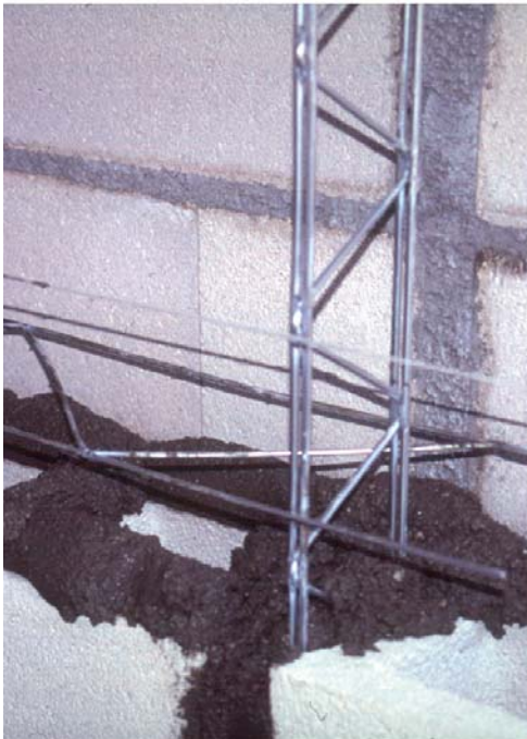
Figura 5.- c) Solapado del armado Murfor del paño izquierdo acometiendo la Costilla AllWall.
