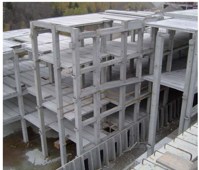
Figura 16.- Limpieza de la obra prefabricada.
