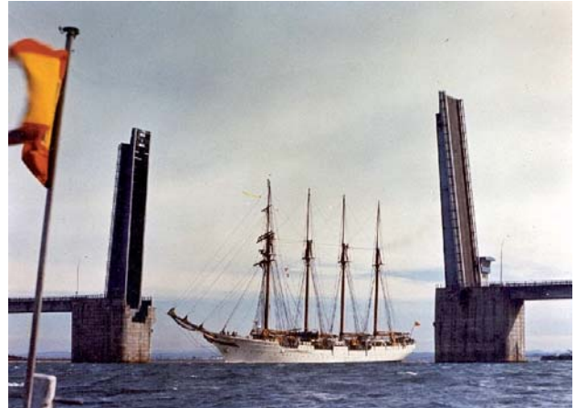
Figura 3.- Puente sobre la Bahía de Cádiz.
