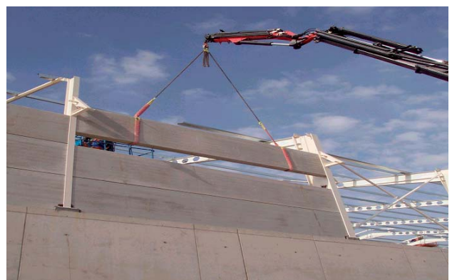
Figura 22.- Colocación como cerramiento lateral.
