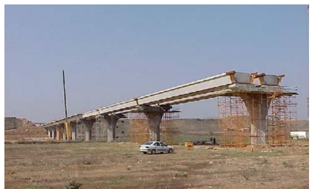
Figura 13.- Tablero doble prefabricado de AVE con continuidad hiperestática .
