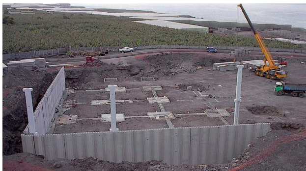
Figura 20.- Muro de contención de tierras en semi-sótano.
