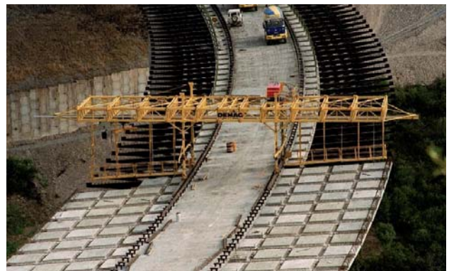
Figura 34.- Losas prefabricadas con espesor total sobre estructura de acero (cajón y jabalcones).
