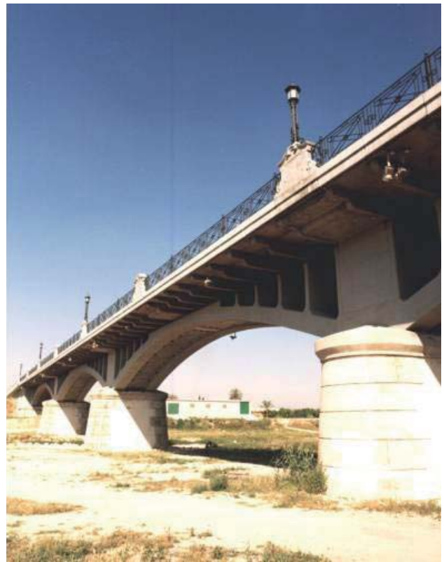
Figura 23.- Puente con tableros de arcos prefabricados.
