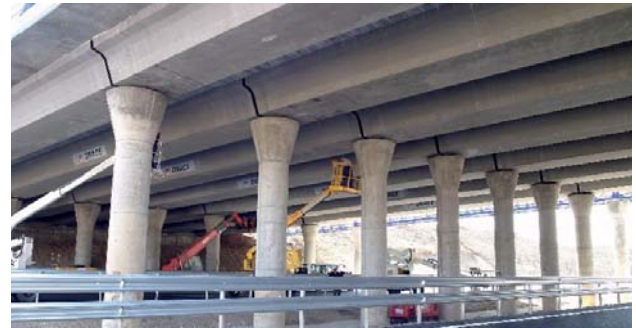
Figura 26.- Puente con tableros de vigas U.
