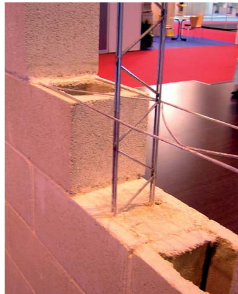
Figura 9.- b) Imagen de un caso de costilla embutida lateralmente dentro de la pieza del BLOC+.
