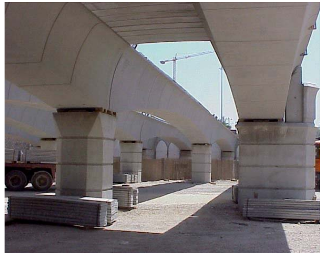
Figura 30.- Apilado de losas de encofrado perdido.
