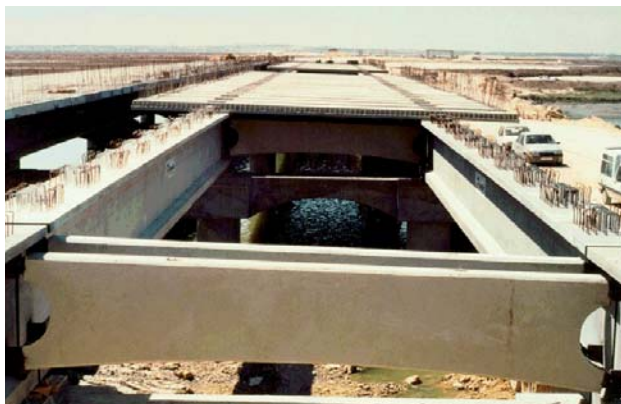
Figura 32.- Losas prefabricadas de tablero con espesor total.
