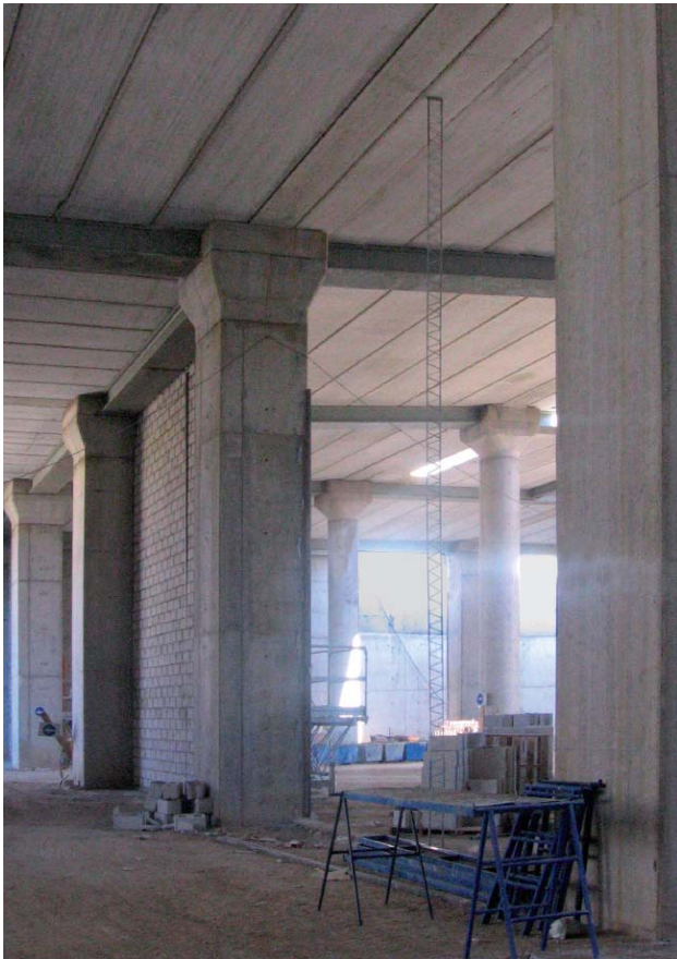
Figura 18.- Costilla AllWall AW-COS.10/Z-140 mm fijada en el centro de la partición de 9 m de largo x 9m de altura, en el Aeropuerto de Málaga.
