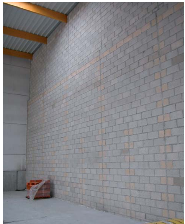
Figura 14.- Partición interior del Centro Comercial Eroski de Vitoria, empotrada abajo y libre arriba. Muro de 11m de alto en 2 tramos, inferior con BHH de 29cm y superior con BHH de 19 cm, y con costillas de distinta altura para soportar el muro en ménsula.
