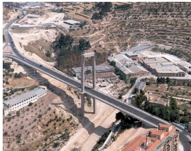
Figura 38.- Puente atirantado con tablero prefabricado.
