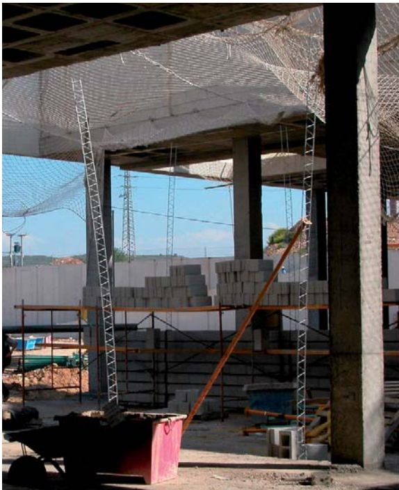
Figura 11.- a) Costillas verticales ya fijadas inferiormente, preparadas para construir un muro industrial.
