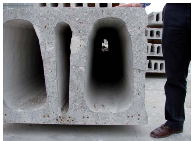
Figura 9.- Losa de gran canto.
