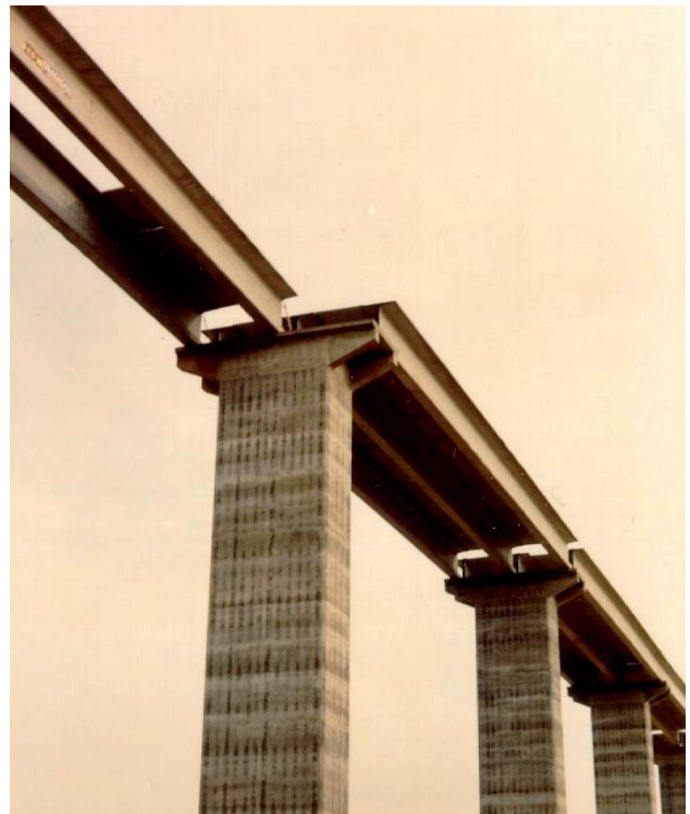
Figura 48.- Cabecero prefabricado sobre pilas "in situ".
