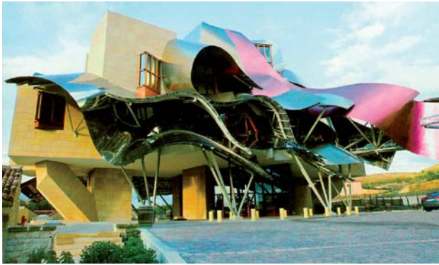
Figura 17.- Hotel Marqués de Riscal de F.O. Ghery, donde se ha empleado el Sistema de Albañilería Integral, SAI.
