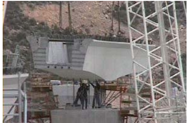
Figura 17.- Pieza de cantilever sobre la pila.
