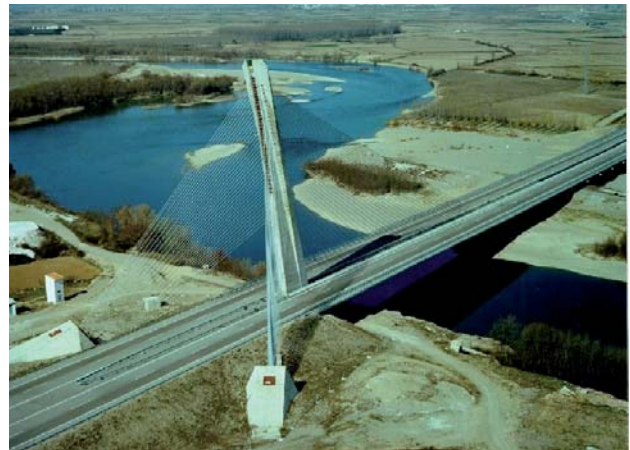
Figura 37.- Puente atirantado con dovelas de media sección del tablero.
