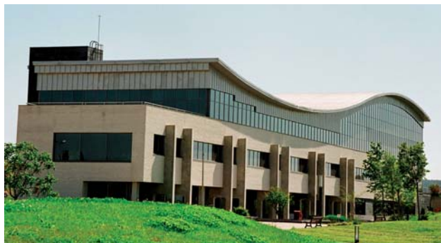
Figura 3c.- Empleo de mampostería de hormigón en edificación pública.
