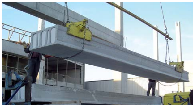
Figura 25.- Manipulación de la losa alveolar.
