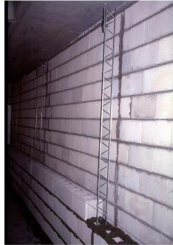
Figura 6.- b) Costillas AllWall distanciadas a 2,80m entre sí, dispuestas en llaga vertical continua (en muro cortafuego doble de la Terminal T4 del Aeropuerto Madrid-Barajas).
