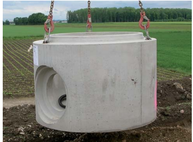
Figura 17.- Pozos de inspección de hormigón de alto rendimiento doblemente resistentes a la corrosión.
