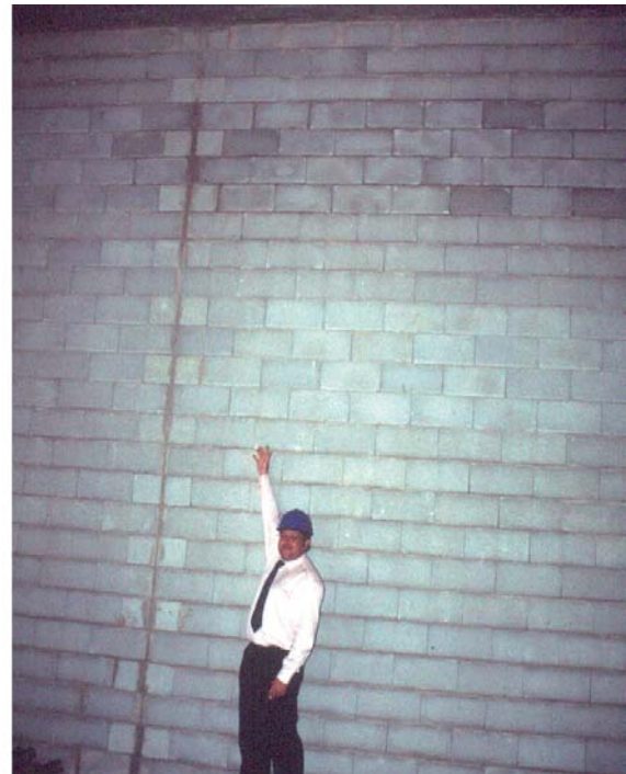
Figura 11.- b) Costilla en llaga vertical continua, en un muro de bloque para revestir de 6m de alto.
