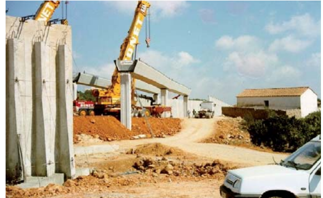
Figura 44.- Estribo prefabricado con contrafuertes.
