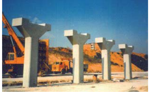
Figura 47.- Pilas de columnas independientes con capitel simple.
