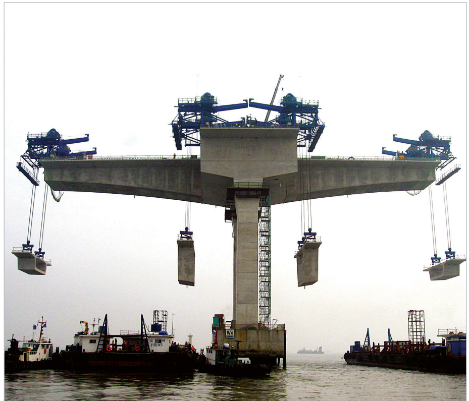
↑ Construcción de un puente off-shore mediante el empleo de cajones prefabricados de concreto para la formación del tablero.
