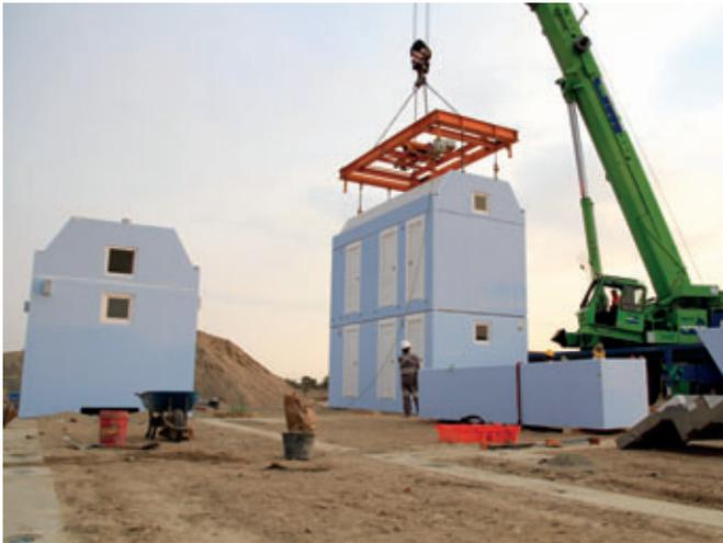
Fig. 15: Montaje final en obra
