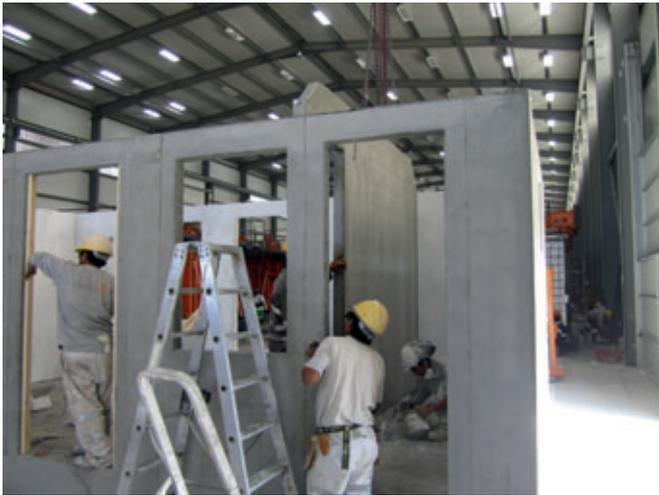
Fig. 13: El acabado de los módulos de ambiente se realiza en fábrica
