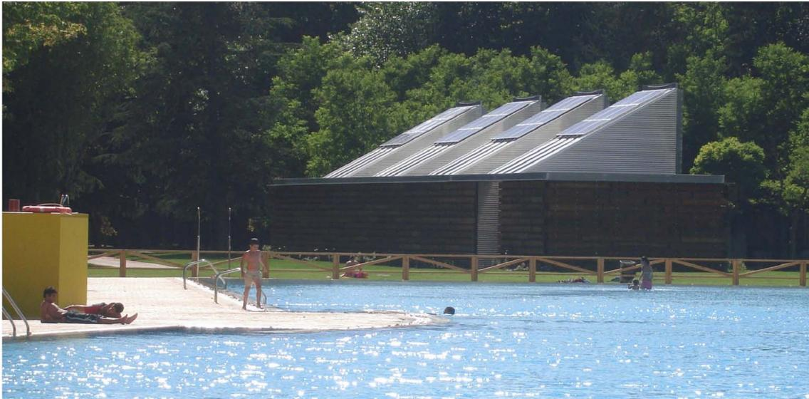
La necesidad de adaptarlas a las nuevas normativas requería de la construcción de un nuevo edificio de depuración. Las dimensiones en planta se derivan del tamaño y número de filtros necesarios. Se optó por integrar el edificio en el paisaje. Se puede recorrer e incluso atravesar por un camino que divide el programa en la zona de filtros y la zona de electroválvulas y cuadros eléctricos.
