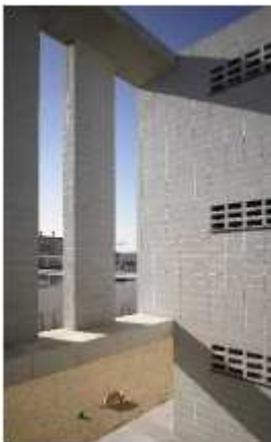
La escuela se construye en **bloque de hormigón blanco** con junta vertical y una serie de celosías también de hormigón en solución de continuidad interior y exterior que configuran el lenguaje del edificio.
