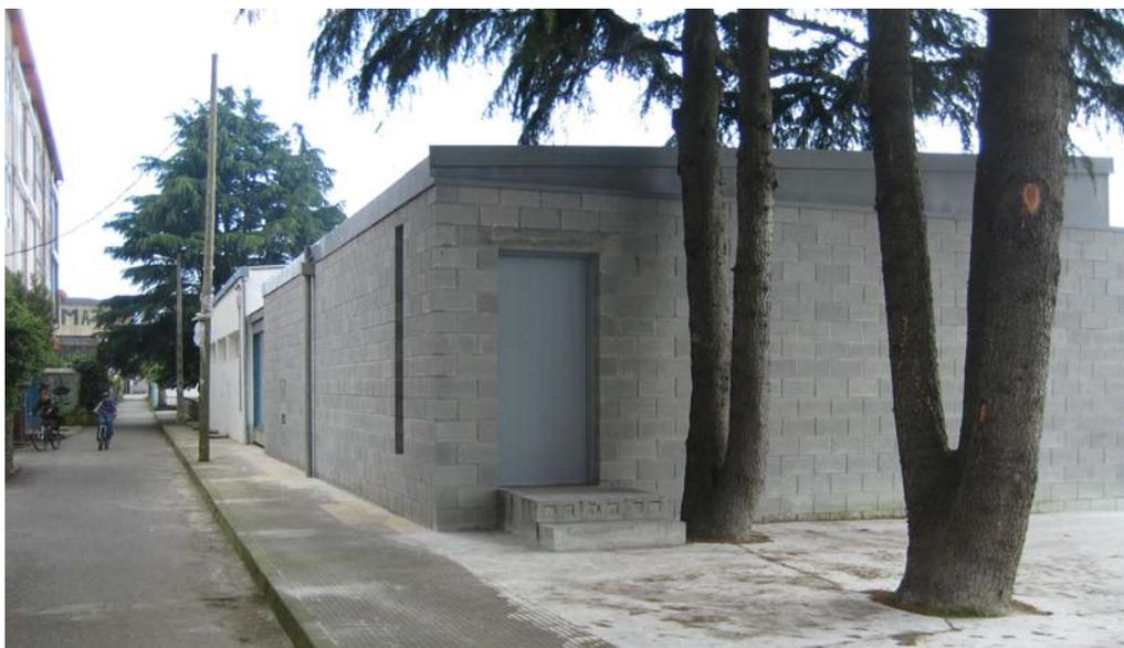
La parte posterior del edificio realizada en fábrica de bloque además de su capacidad de cerramiento y colaboración estructural de arriostramiento, antes citada, no se reviste ni pinta ofreciendo con su acabado natural, una superficie de tacto poco agradable a las pinturas y grafitis que en esta zona de la ciudad son habituales.
