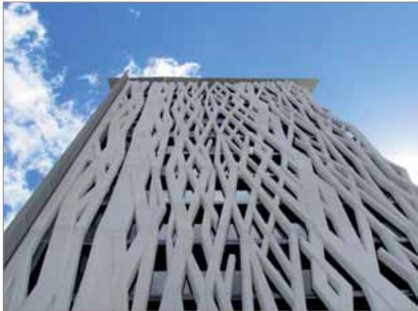
■ Foto 3. Fachada con revestimiento exterior de hormigón polímero.
