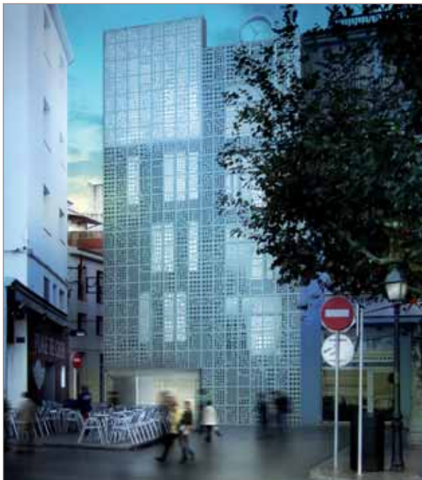
■ Foto 3. Fachada con revestimiento exterior de hormigón polímero.
