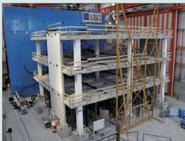
■ Foto 7. Ensayos sobre estructura prefabricada de hormigón de 3 plantas de altura pertenecientes al proyecto SAFECAST (2009-2012). Se trata del edificio prefabricado de mayores dimensiones jamás ensayado frente a sismo.
