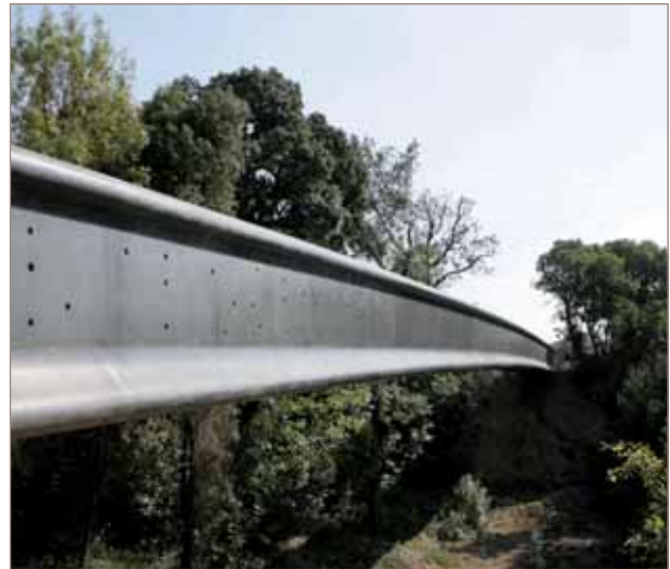
■ Foto 4. Pasarela 'Pont du Diable', diseñada por el arquitecto Rudy Ricciotti y el ingeniero Román Ricciotti. 70 metros de longitud de hormigón de muy altas prestaciones reforzado con fibra de acero (UHPFRC).
