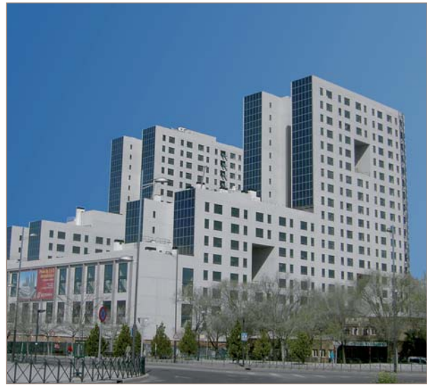
■ Figura 6. Edificio de viviendas en Coslada (Madrid) de 20 alturas sobre rasante, resuelto mediante sistema constructivo de paneles portantes prefabricados de hormigón.
