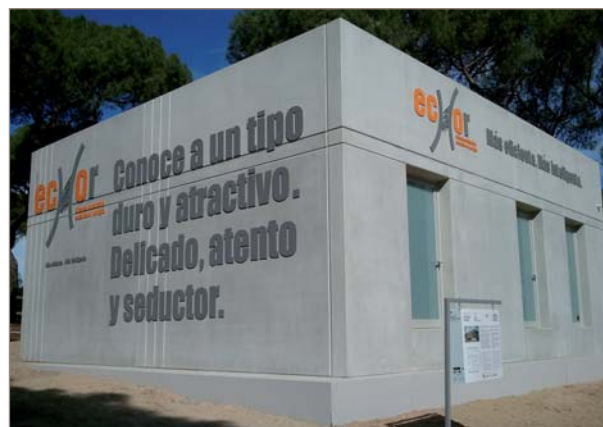
■ Figura 3. Edificio ECHOR, construcción totalmente prefabricada en hormigón presentada en el certamen internacional Solar Decathlon celebrado en Madrid en 2012.
