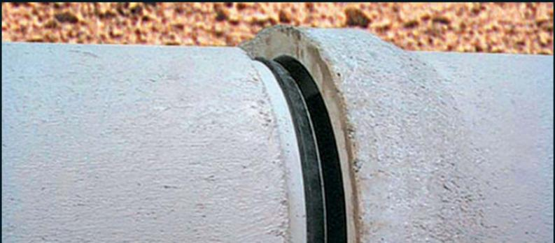
**Las tuberías de hormigón armado se diseñan con uniones que garantizan la estanquidad mediante juntas elastoméricas**
