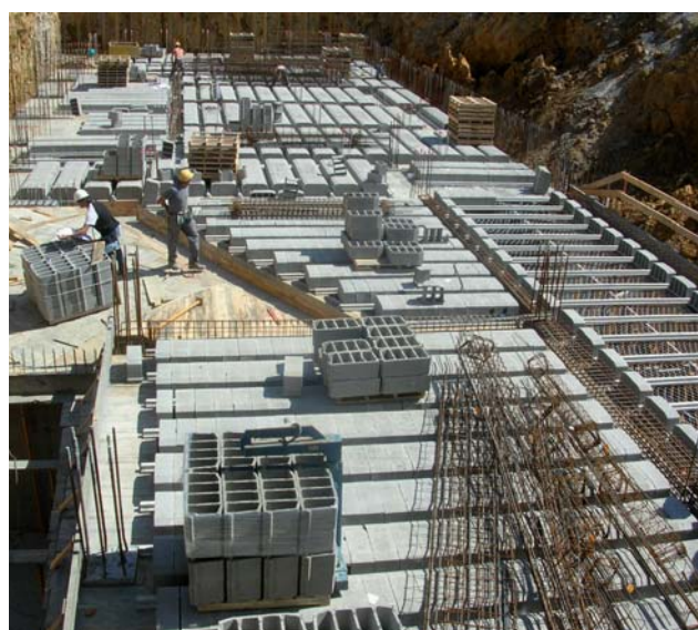
Figura 1.- Vista general de instalación del sistema de forjado: viguetas, bovedillas y zuncho perimetral. Foto: PRENOR.
