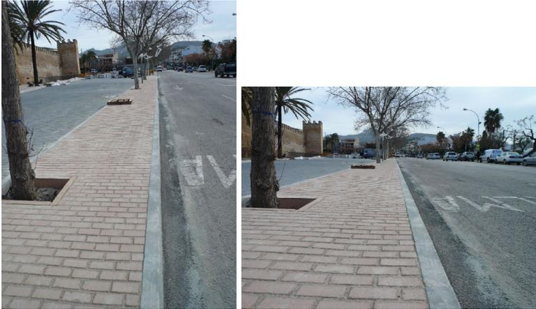
Fig. 11: Pavimento de 300m<sup>2</sup> con adoquines reciclados, Alcudia.
