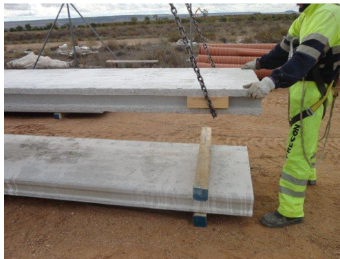
Figura.- Descarga de placas alveolares
