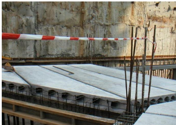
Figura.- Placas con un corte oblicuo efectuado en fábrica, ya instaladas en el forjado
